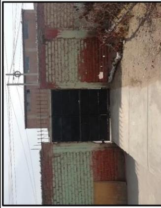
En las fotografías se puede apreciar tomas de distintas partes del muro perimetral del CEBE, en ellas se nota el marcado deterioro de los ladrillos por humedad, ya que en su mayoría el muro perimetral no cuenta con sobre cimientto que ayude a atenuar el contacto con la humedad del suelo, esta misma situación se replica en las aulas.
