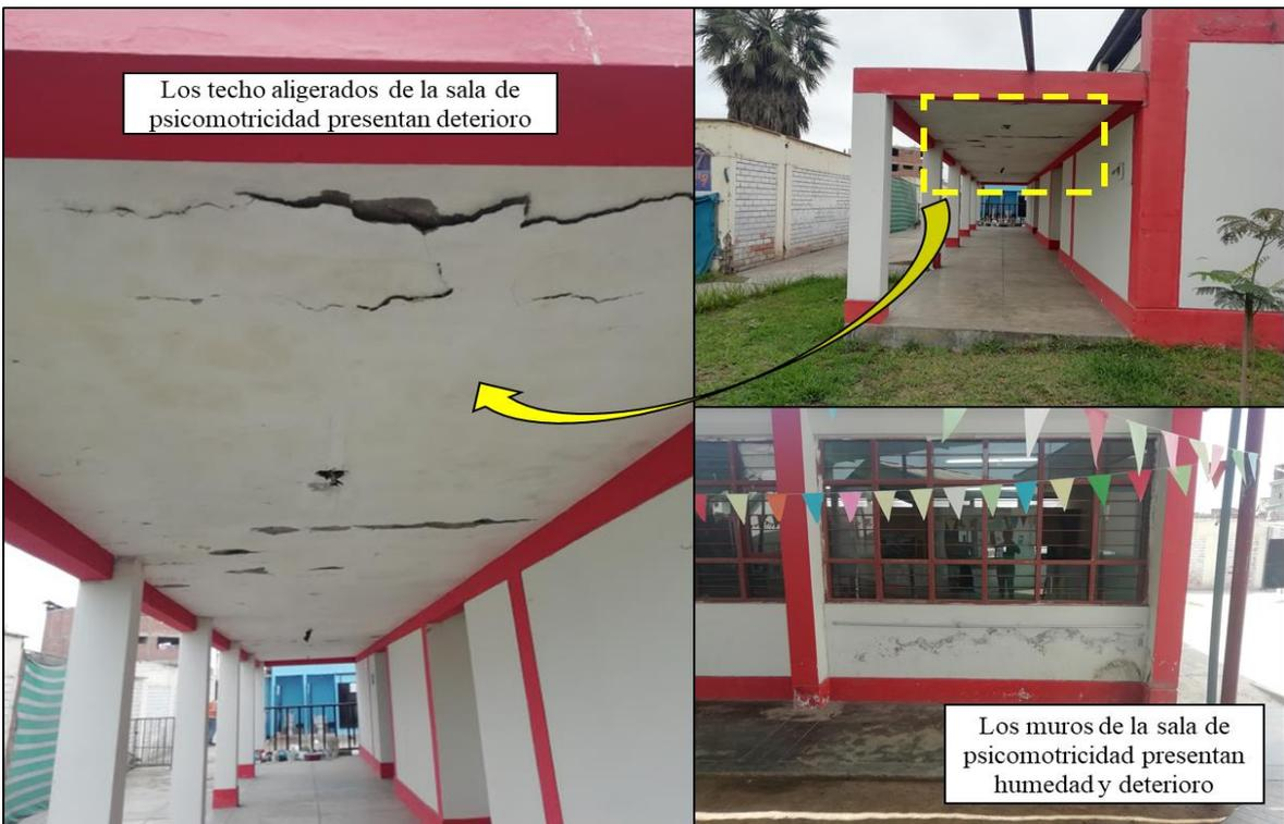
**FIGURA 32.** Deterioro en los techos de la sala de psicomotricidad
