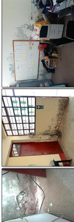
Se observa la presencia de humedad en la base de los muros y tabiques, se nota la ausencia de sobre cimientos.
