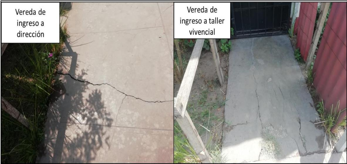
**FIGURA 24.** Veredas interiores deterioradas
