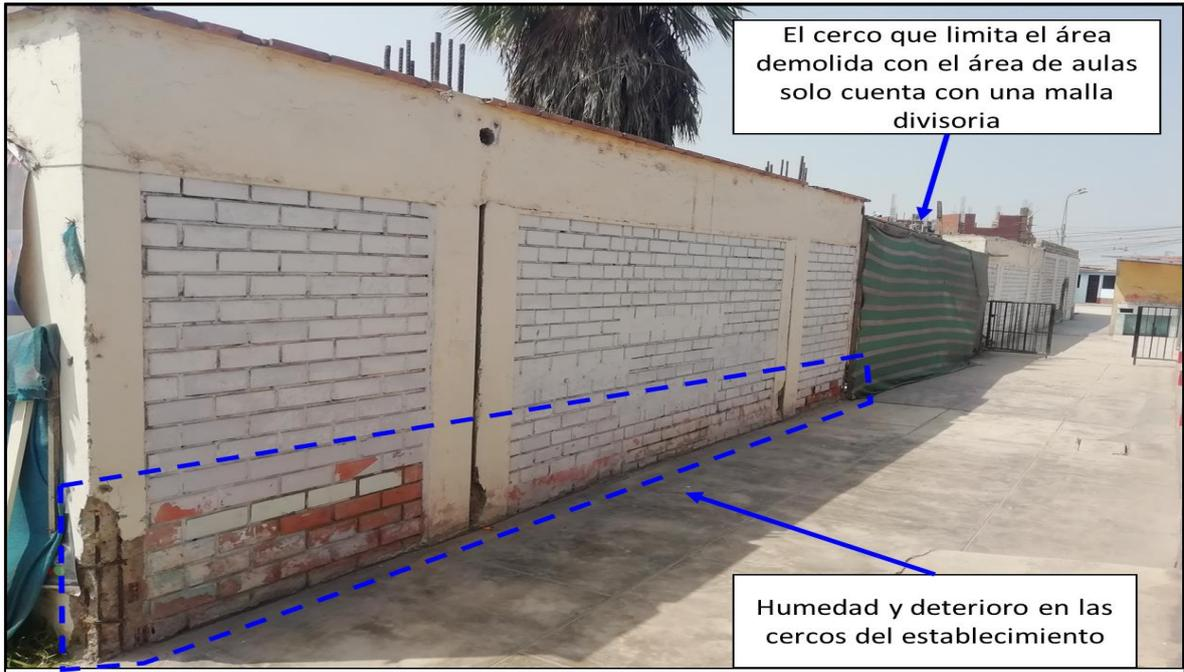
**FIGURA 25.** Estado actual del cerco interior que divide el área demolida de la zona de aulas – Toma 01
