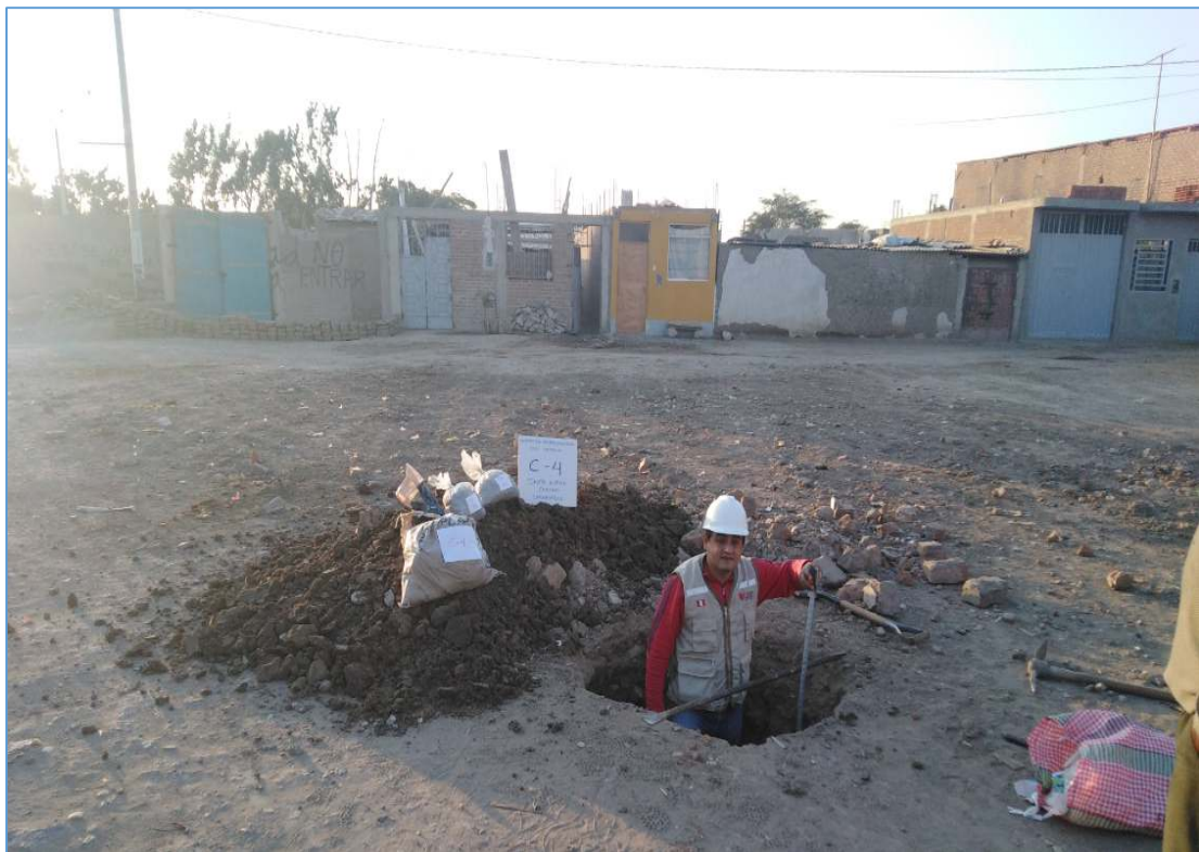
FOTO N° 08 - Vista a cielo abierto de las muestras extraídas y profundidad en C - 04
