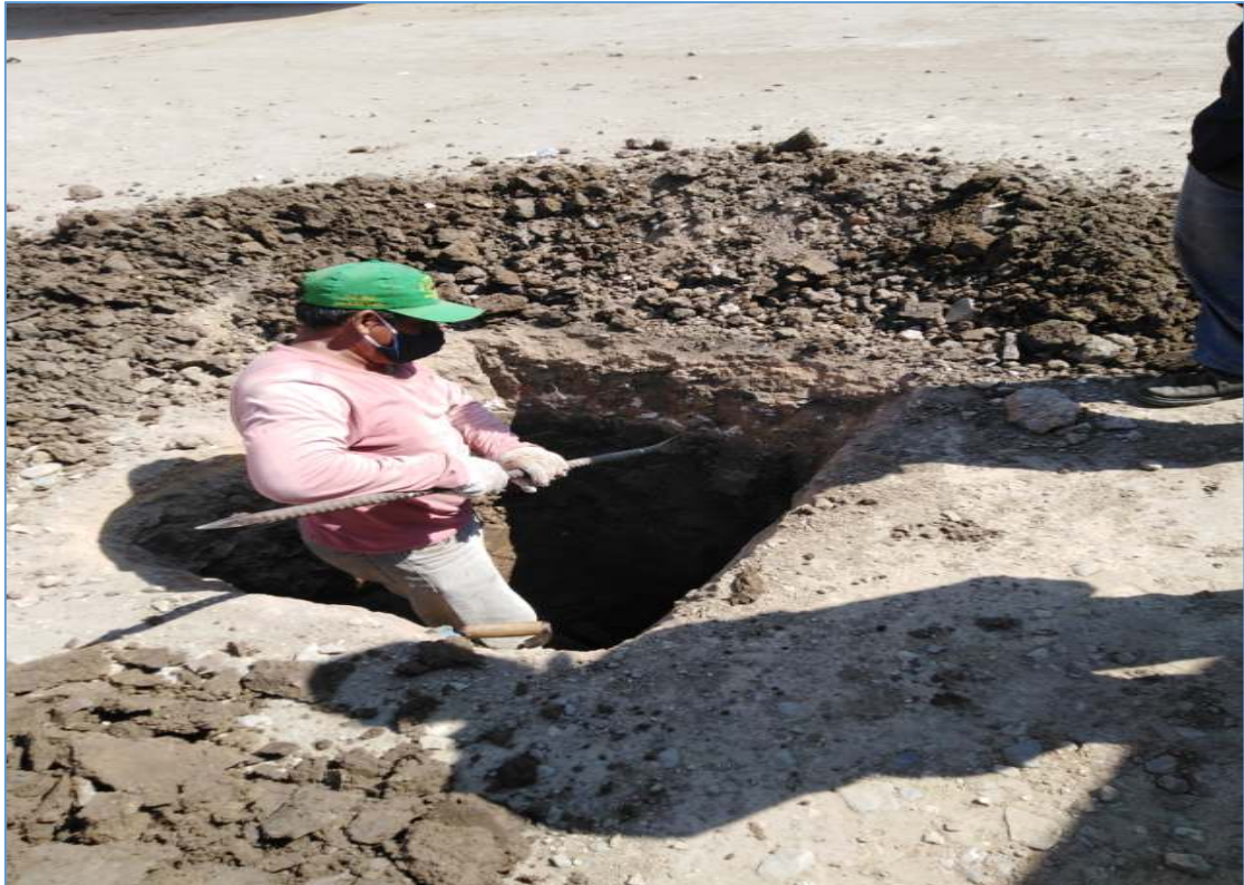
FOTO N° 09 - Vista a cielo abierto de la excavación de muestras en C - 05
