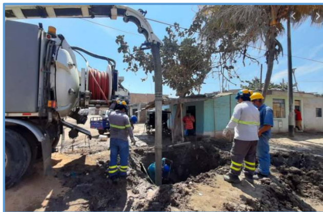
Figura 15.Reparación de tubería matriz de agua potable por parte de EPSEL
