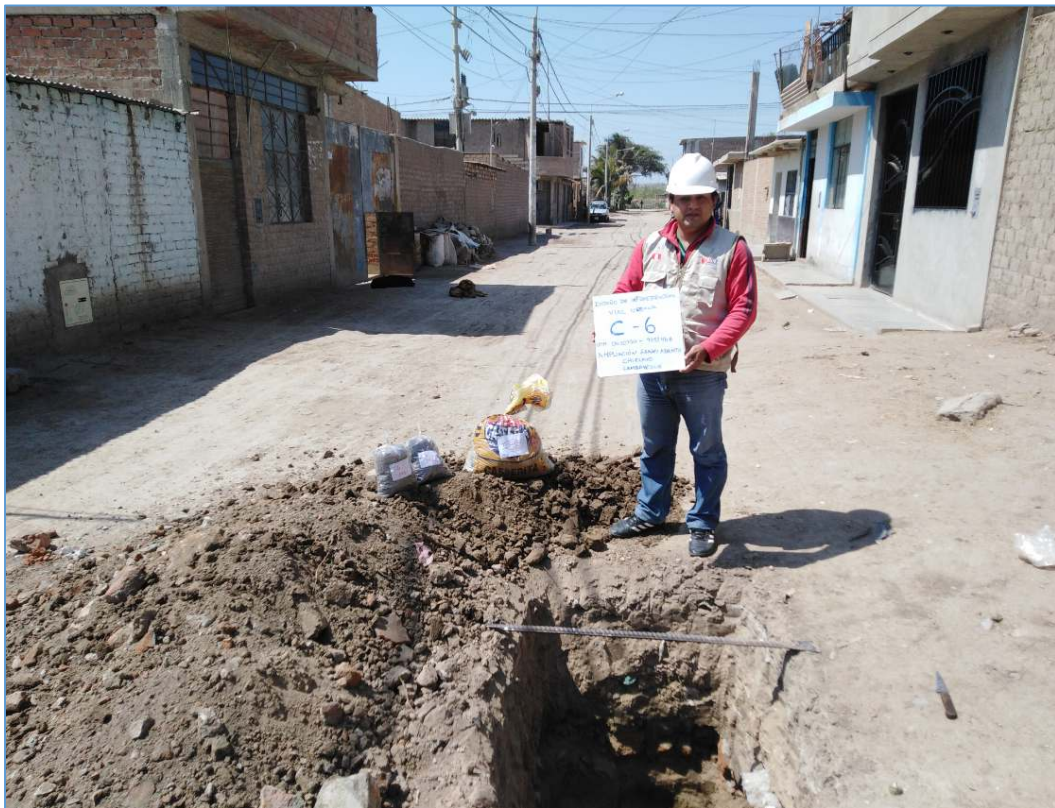
FOTO N° 12 - Vista a cielo abierto de las muestras extraídas en C - 06
