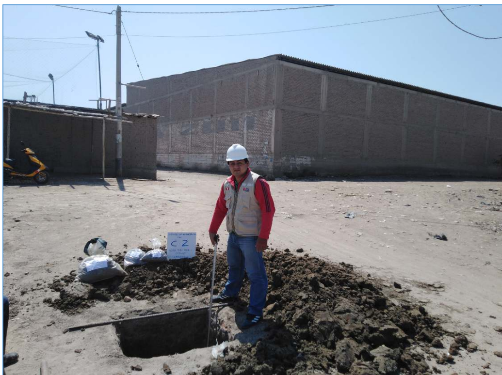
FOTO N° 04 - Vista a cielo abierto de la extracción de muestras en C - 02
