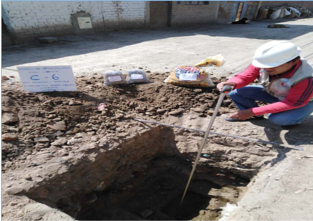
FOTO N° 11 - Vista a cielo abierto de la excavación y profundidad en C - 06
