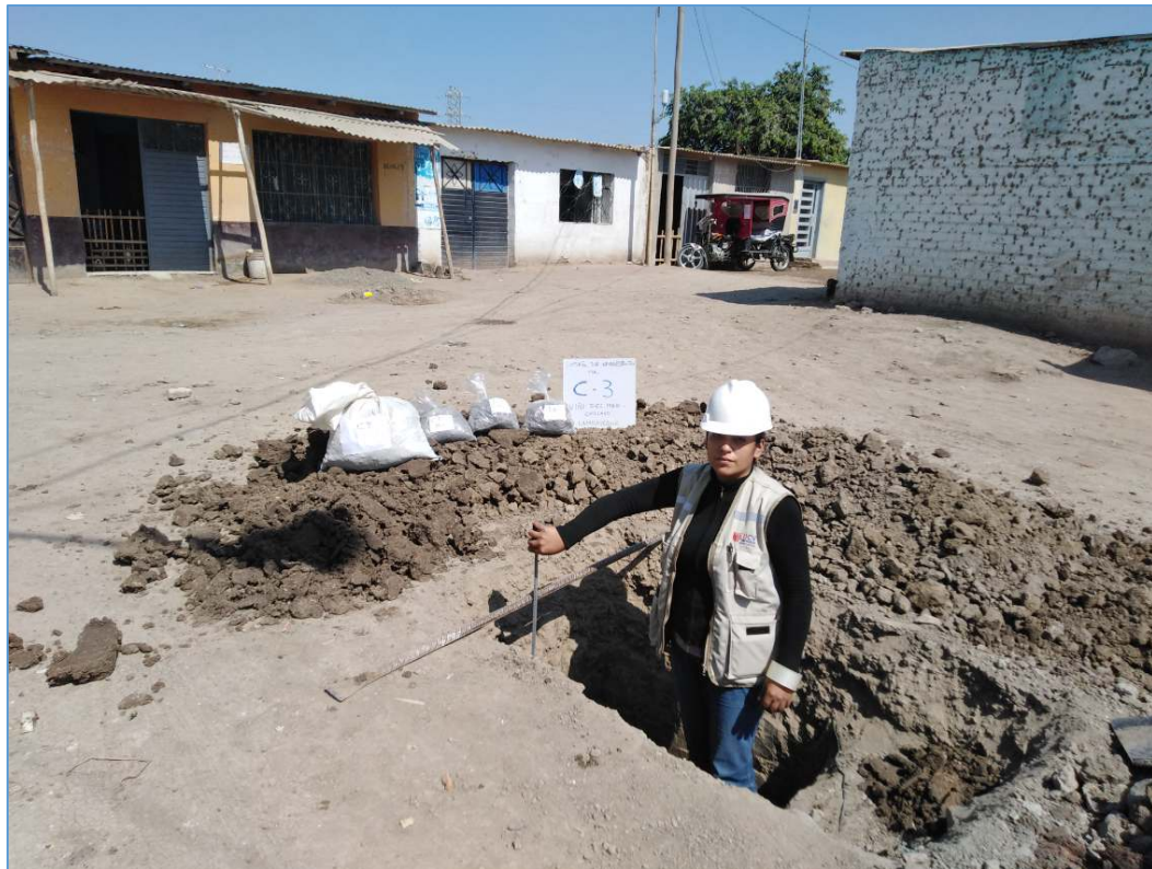
FOTO N° 06 - Vista a cielo abierto de las muestras extraídas en C – 03
