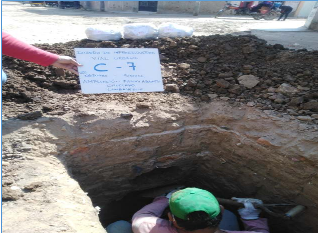
FOTO N° 13 - Vista a cielo abierto de la excavación y extracción de muestras en C - 07
