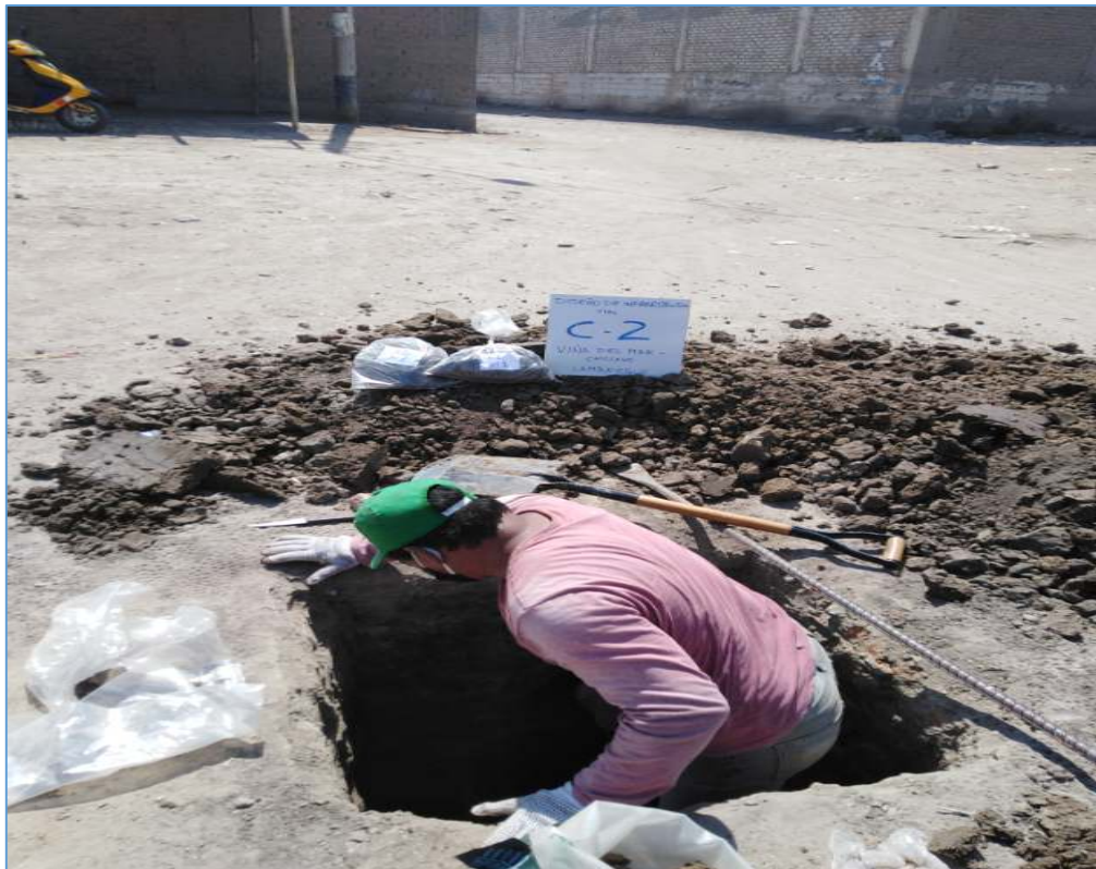
FOTO N° 03 - Vista a cielo abierto de la excavación en C - 02
