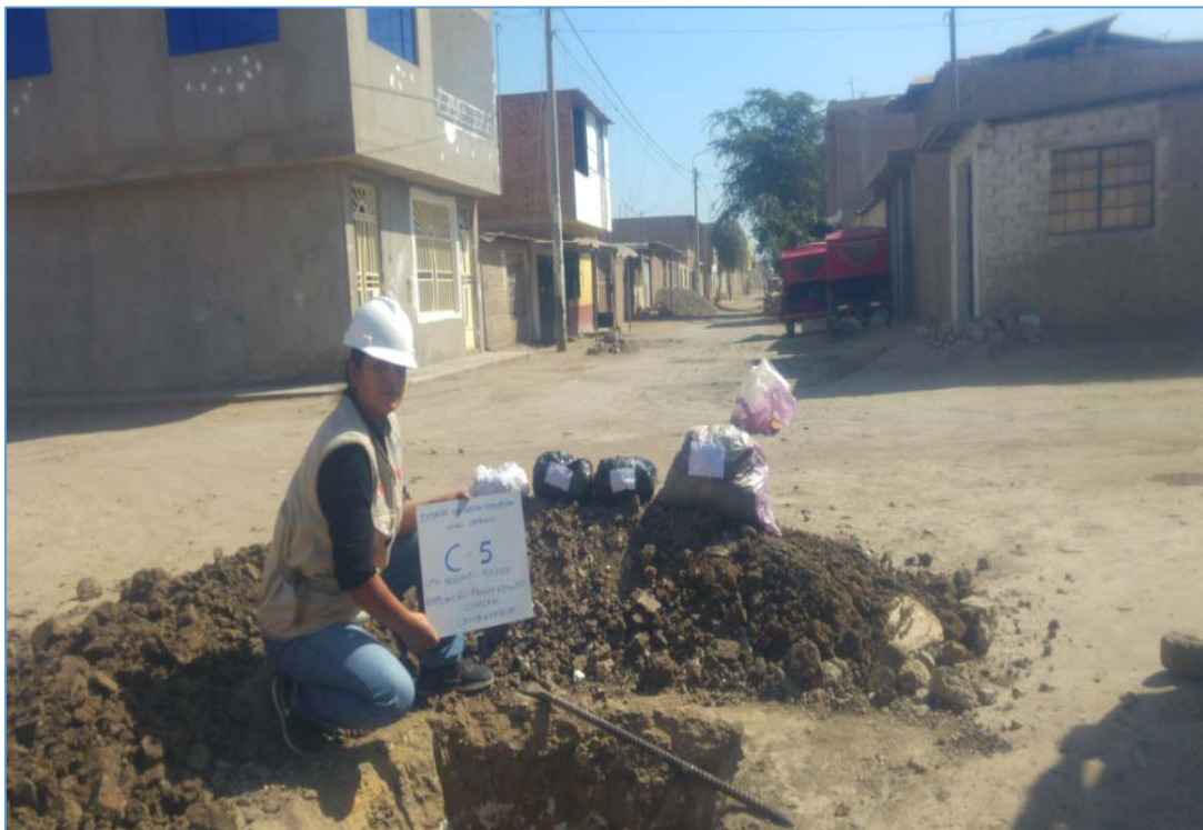
FOTO N° 10 - Vista a cielo abierto de las muestras extraídas en C - 05
