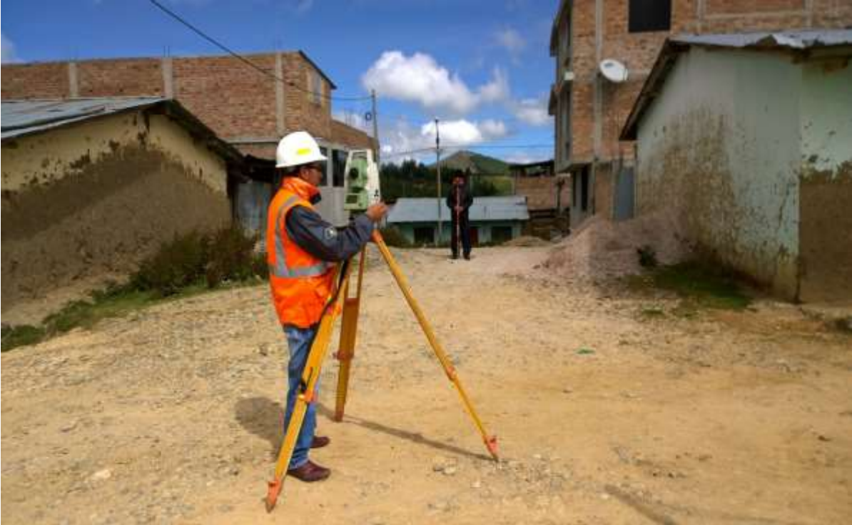
Levantamiento de Jr. Los Andes Vista de Jr. Los Bambamarca hacia Jr. Chota)
