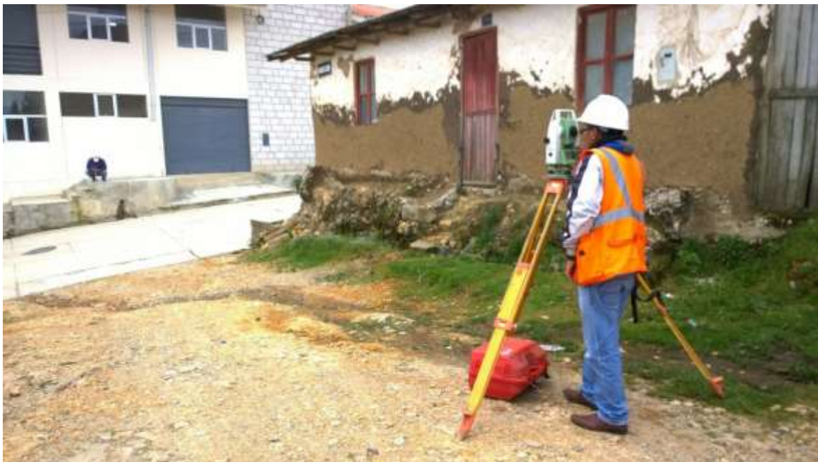
Colocación de BMs en vereda del Jr. Cajamarca.
