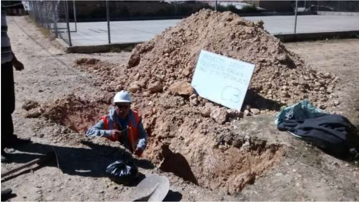
Foto 03 de Estudio de Mecánica de Suelos Calicata N° 03.
