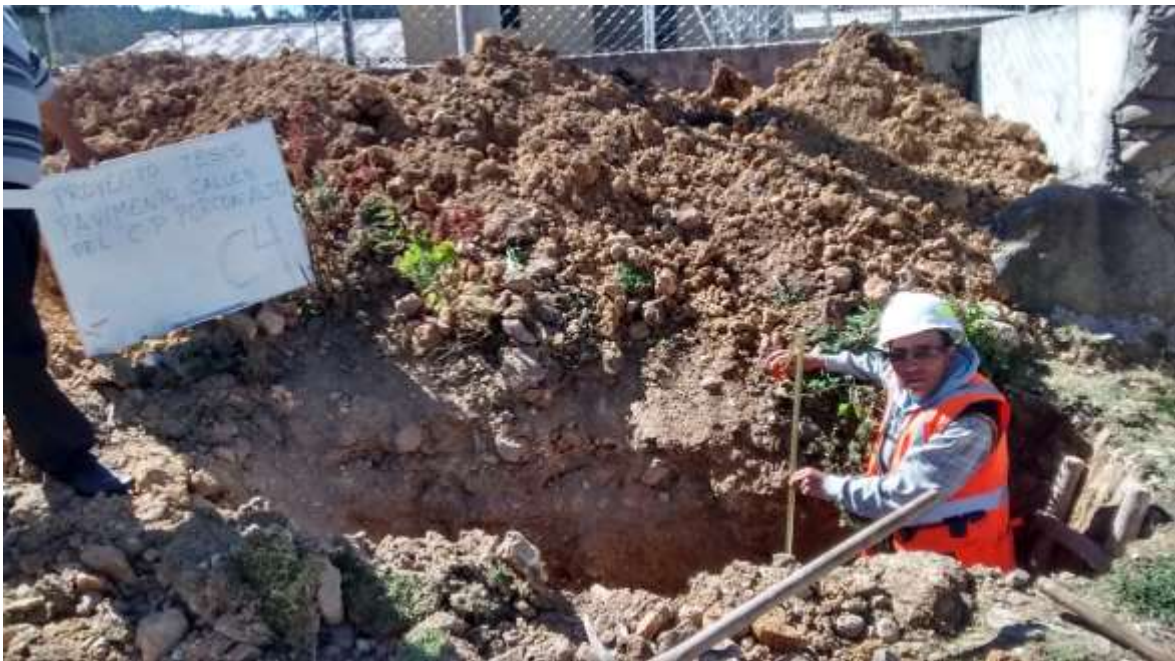
Foto 04 de Estudio de Mecánica de Suelos Calicata N° 04.
