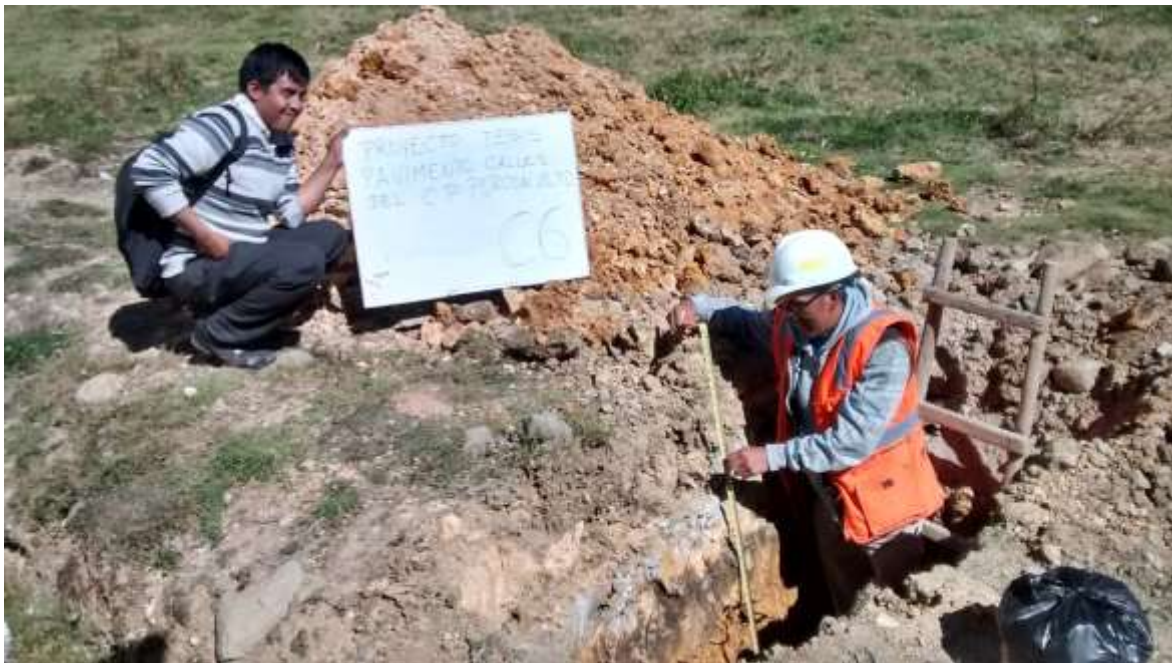
Foto 06 de Estudio de Mecánica de Suelos Calicata N° 06.
