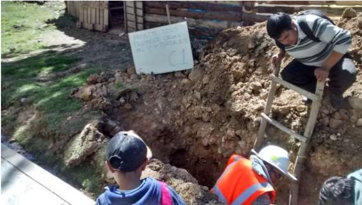
Foto 01 de Estudio de Mecánica de Suelos Calicata N° 01.
