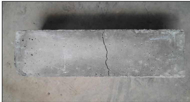
Figura 47. Especimen prismático fisurado.
