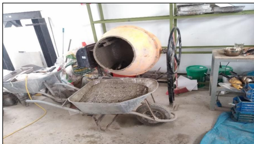
Figura 32. Mezcla de concreto.
