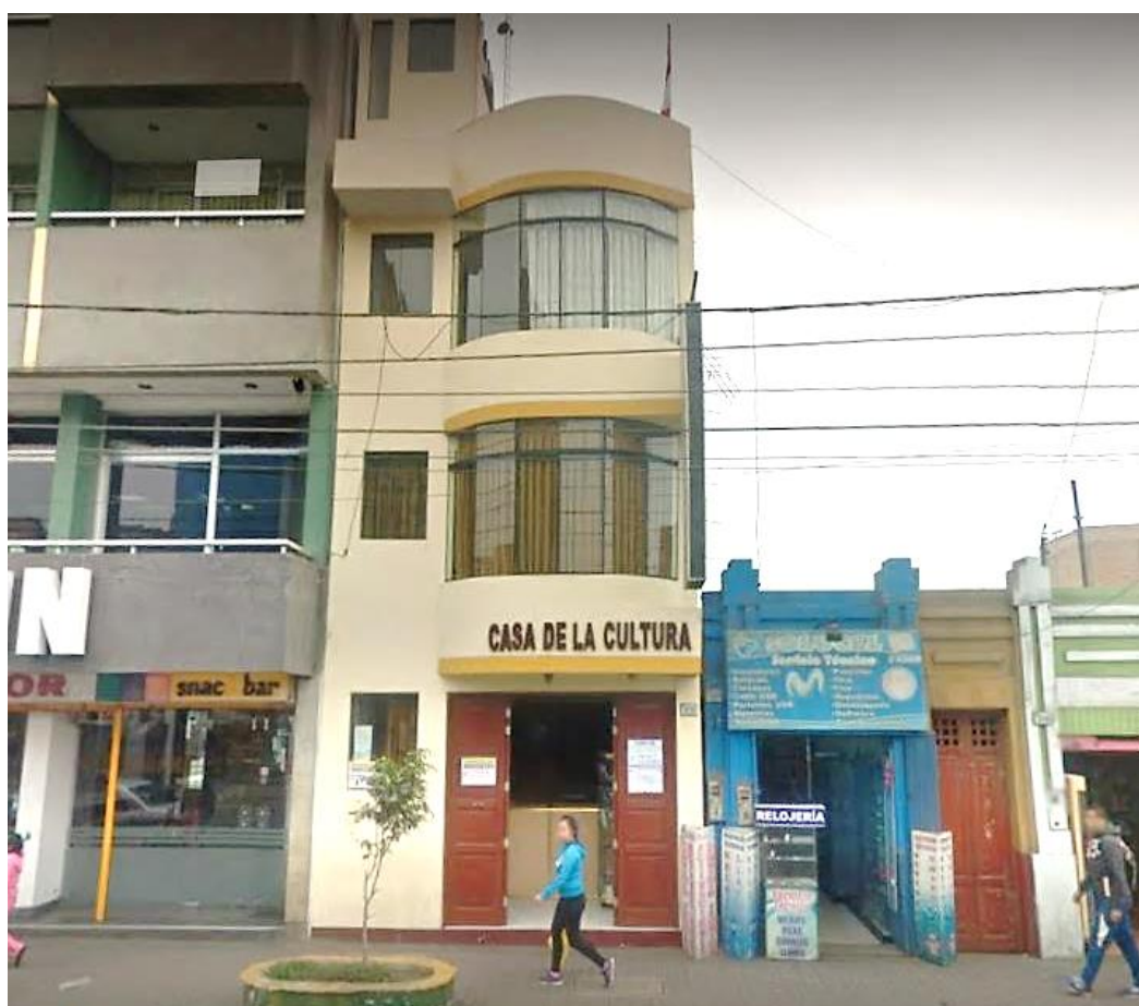
Ingreso de la Casa de la Cultura de Barranca
