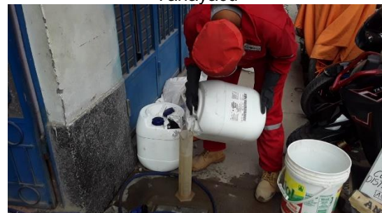
Fotografía N° 40: Personal de laboratorio cuantificando cantidad de agua de la laguna de Yanayacu para la preparación de concreto
