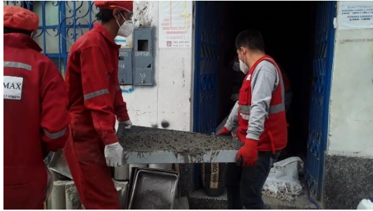
Fotografía N° 41: Traslado del concreto preparado para la elaboración de las probetas y vigueta preparado para la elaboración de las probetas y briquetas
