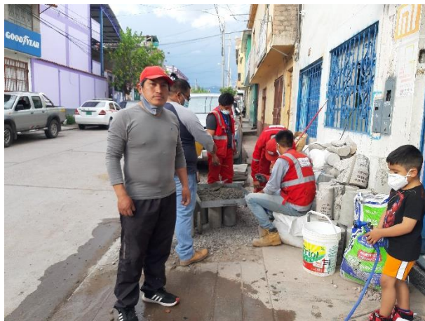
Figura 20. Ensayo de Asentamiento para el concreto preparado con agua patrón
