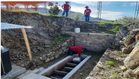
Fotografía N° 21: Recolección de agua residual del efluente PTAR Acraybamba para la preparación del concreto
