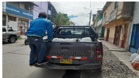
Fotografía N° 24: Traslado del agua residual del efluente PTAR Maucallaqta para la preparación del concreto
