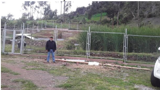
Fotografía N° 03: Vista de la PTAR Accoylla comunidad de Accoylla
