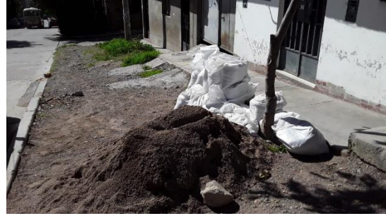
Fotografía N° 26: Compra de la ferretería más cercana, arena gruesa de la cantera Cachi
