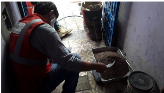
Fotografía N° 29: Pesado de la arena gruesa para la preparación de la mezcla de concreto
