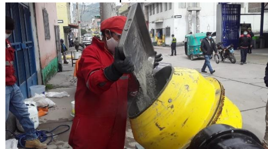
Fotografía N° 38: Personal de laboratorio INGEOMAX vaciando cemento andino a la mezcladora experimental para el preparado de la mezcla con el agua de la laguna de Yanayacu
