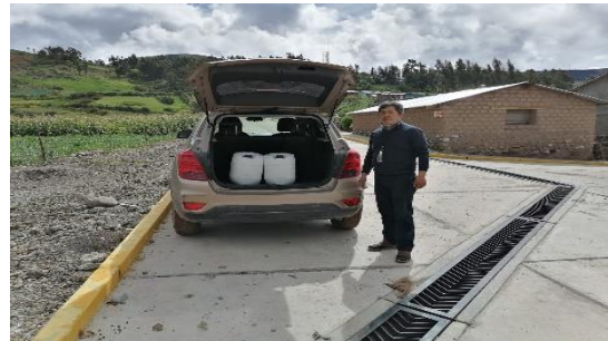
Fotografía N° 20: Traslado del agua de la fuente laguna Yanayacu para la preparación del concreto
