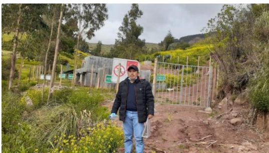
Fotografía N° 07: Vista de la PTAR Larampuquio comunidad de Larampuquio
