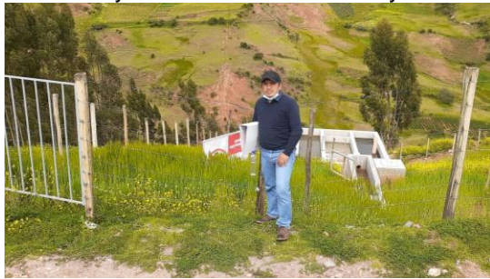
Fotografía N° 11: Vista de la PTAR Pucaloma comunidad de Pucaloma
