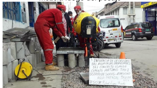
Fotografía N° 32: Personal de laboratorio INGEOMAX realizando el preparado de la mezcla con el agua patrón (agua potable de la ciudad de Ayacucho)
