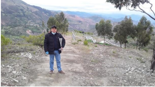
Fotografía N° 01: Vista de la PTAR Acraybamba Simita comunidad de Acraybamba Simita
