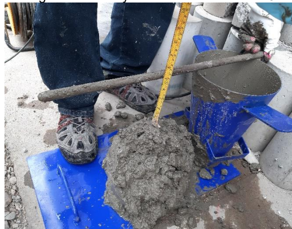
Fotografía N° 50: Medición de la altura del slump para el concreto preparado con agua del afluente PTAR Acraybamba Simita con resultado de 5.5"
