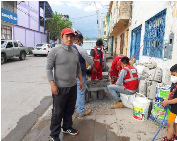
Fotografía N° 43: Ensayo de Asentamiento para el concreto preparado con agua patrón
