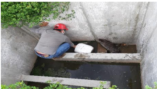
Fotografía N° 23: Recolección de agua residual del efluente PTAR Maucallaqta para la preparación del concreto
