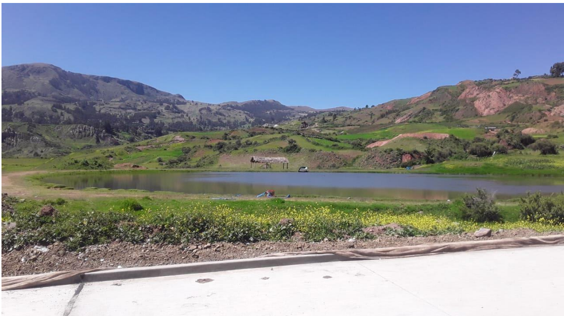
Figura 2. Laguna Yanayacu fuente de agua para la obra, se observa una motobomba para utilizar las aguas de la laguna para elaboración del pavimento rígido
