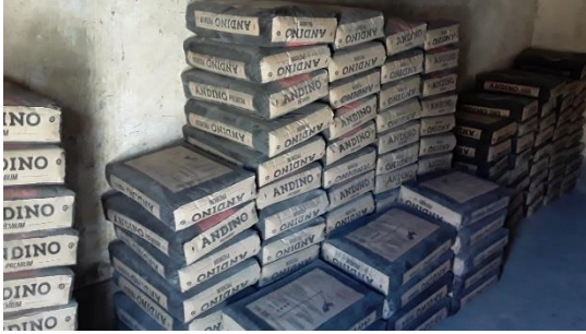
Fotografía N° 25: Compra de cemento andino Portland Tipo I de la ferretería más cercana, se observa la forma y cantidad de apilado
