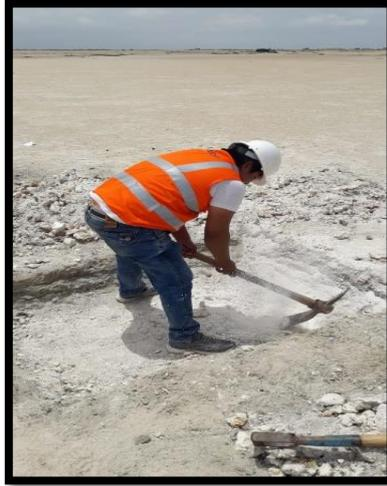
Excavación de Calicatas para la Visualización de la Potencia de Yeso.
