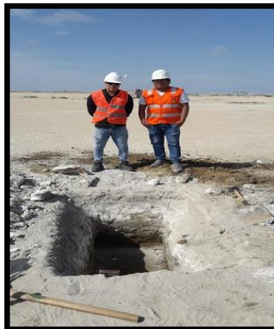
Excavación de Calicata a 2 m de Profundidad.
