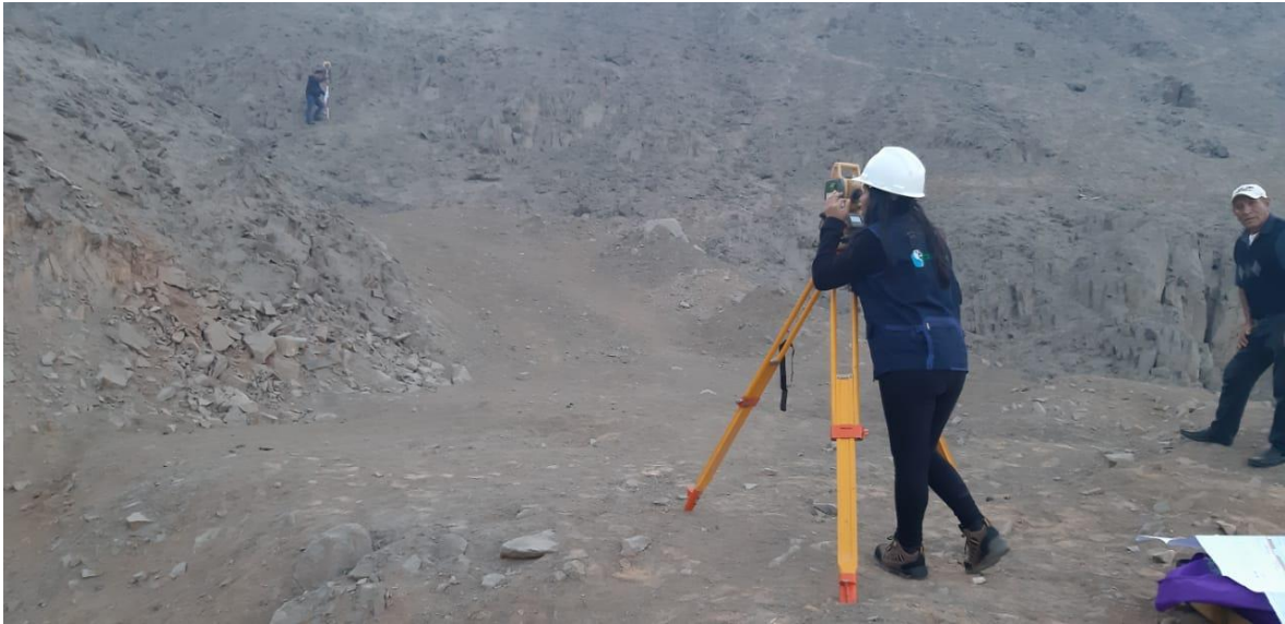
Figura 6. Ubicando los vértices del proyecto
