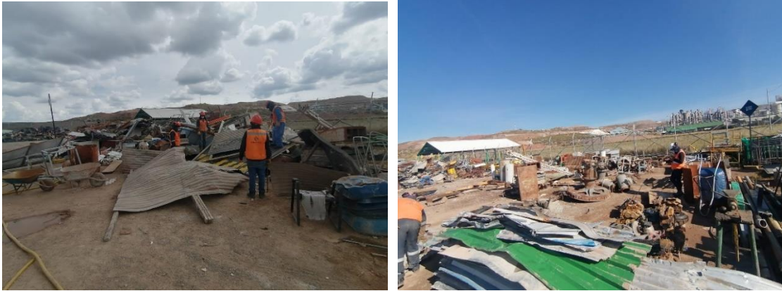
Figura 3. Inspección en Campo.
