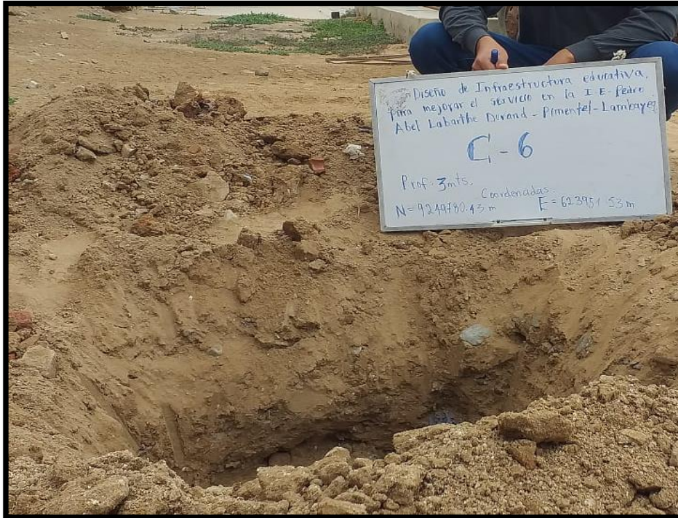
Figura 6. Vista de Calicata C-06 con una profundidad de 3m. en la I.E Pedro Abel Labarthe Durand, Sede Pimentel
