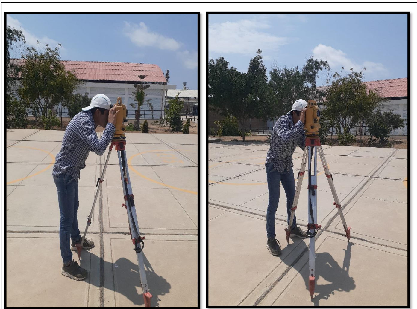
Figura 11. Estación total en el pabellón A de la I.E Pedro Abel Labarthe Durand, sede Pimentel.
