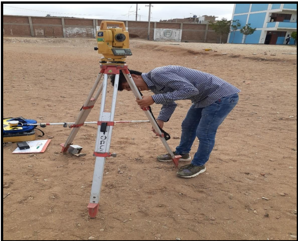
Figura 7. Nivelando la estación total en BM01, en la I.E Pedro Abel Labarthe Durand, Sede Pimentel.
