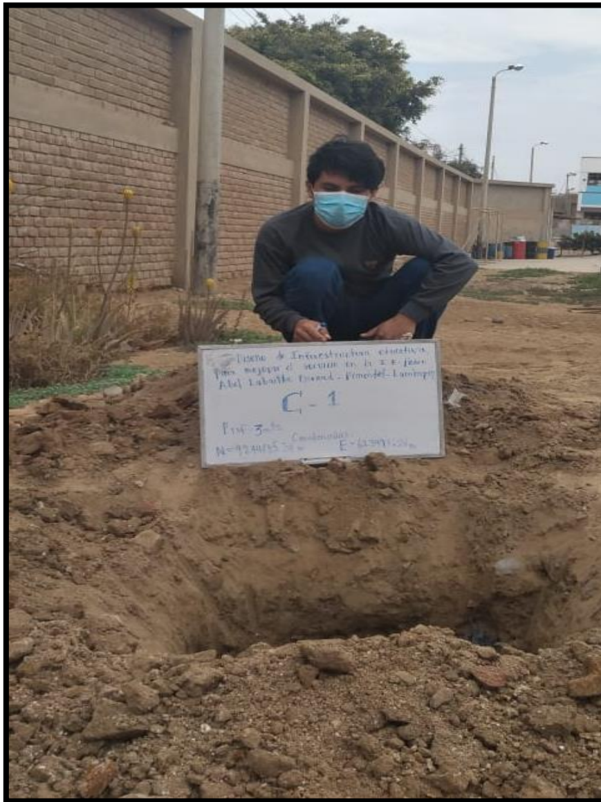
Figura 1. Vista calicata C-01 con una profundidad de 3m. en la I.E Pedro Abel Labarthe Durand, Sede Pimentel.
