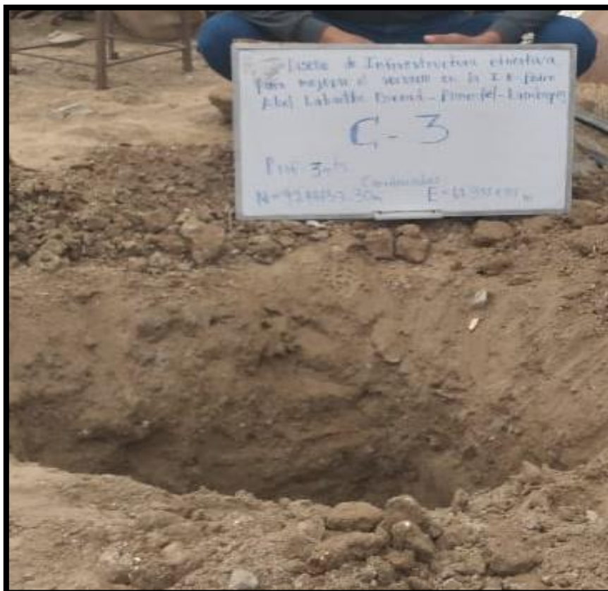
Figura 3. Vista de Calicata C-03 con una profundidad de 3m. en la I.E Pedro Abel Labarthe Durand, Sede Pimentel
