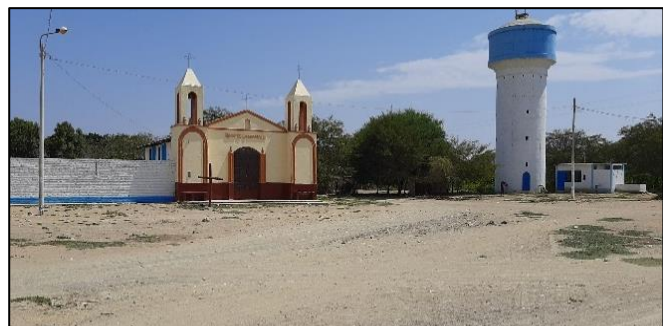
Figura N° 2 Espacio Central Corral de Arena
