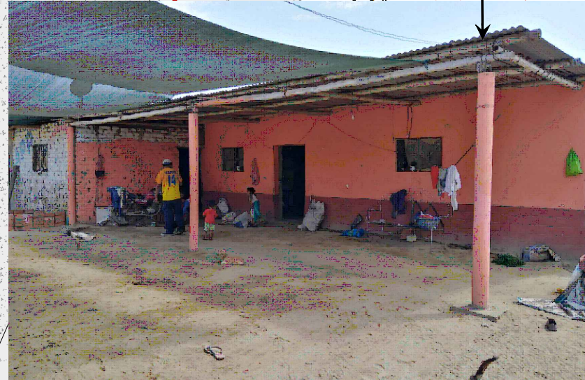
Cobertura de plancha de calamina sobre viga de caña carrizo
