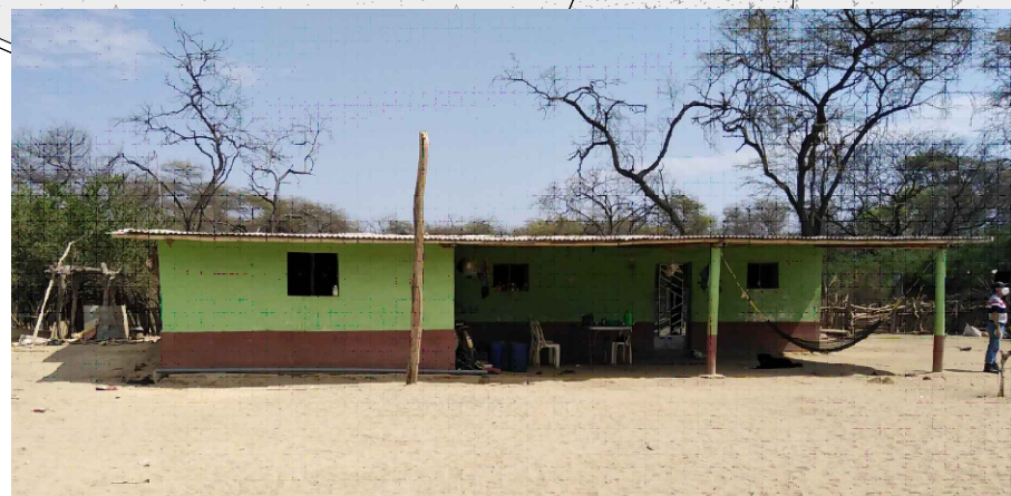
dormitorios con bajo nivel de iluminacion inferior a 50 lux
