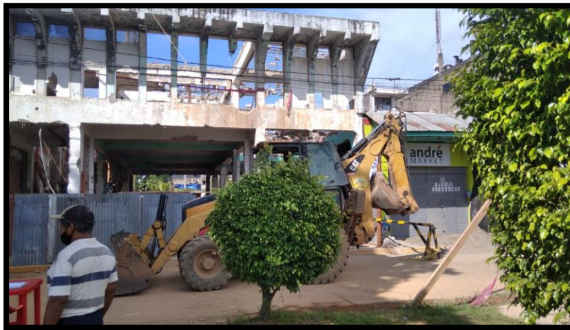
Imagen 1: DEMOLICION DE ESTRUCTURA DE VIGAS Y COLUMNAS PUERTO MALDONADO 2021.
