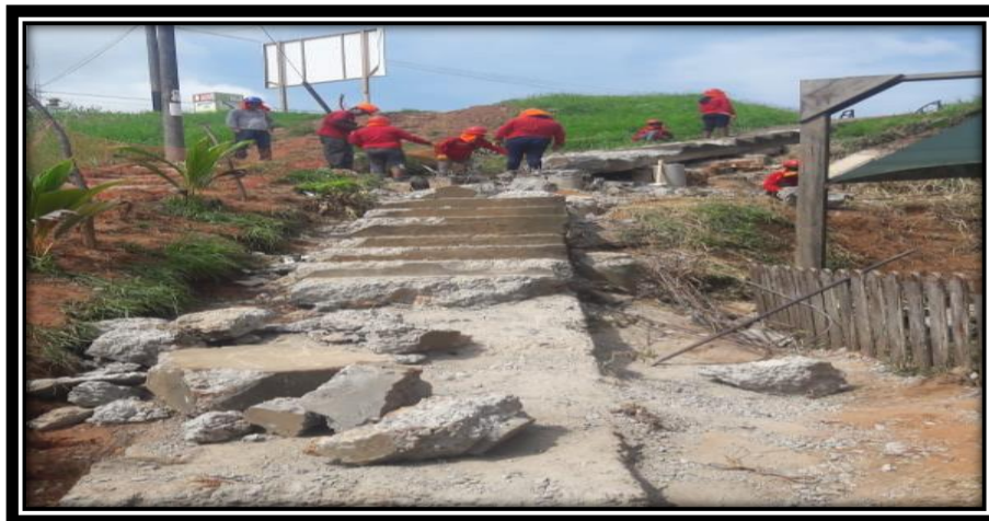
Imagen 28: DEMOLICIÓN DE ESCALINATAS, PARQUE MIGUEL GRAU.
