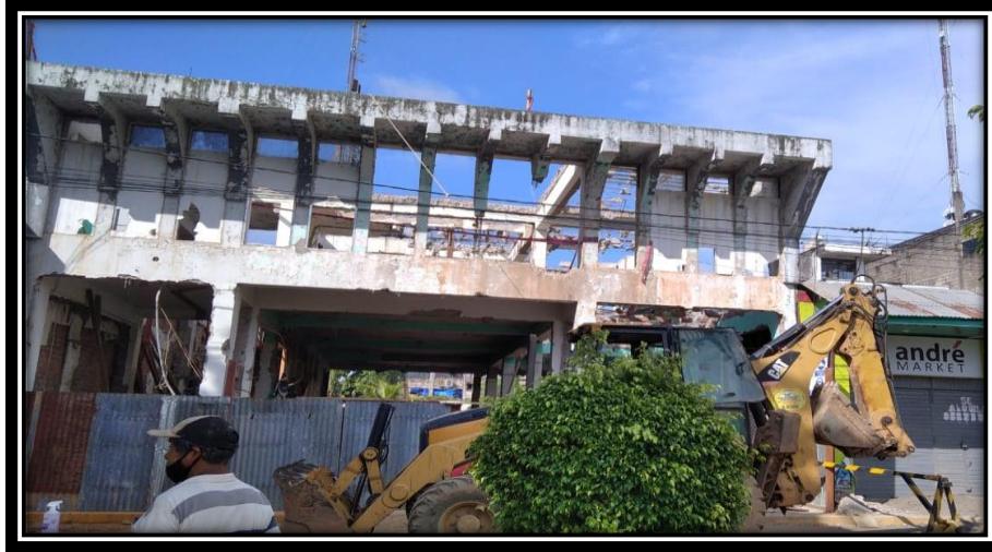
Imagen 29: DEMOLICIÓN DE EDIFICIO, EX BANCO DE LA NACIÓN
