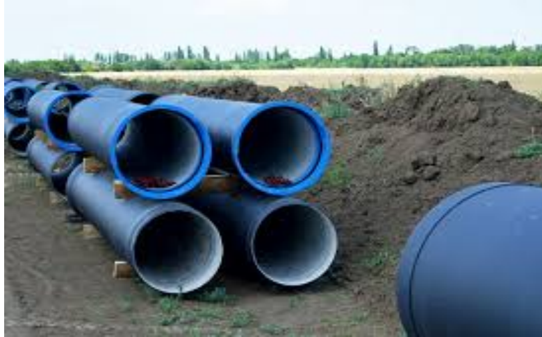
Figura 1. Tubería de HD- K9 para alcantarillado al bombeo
