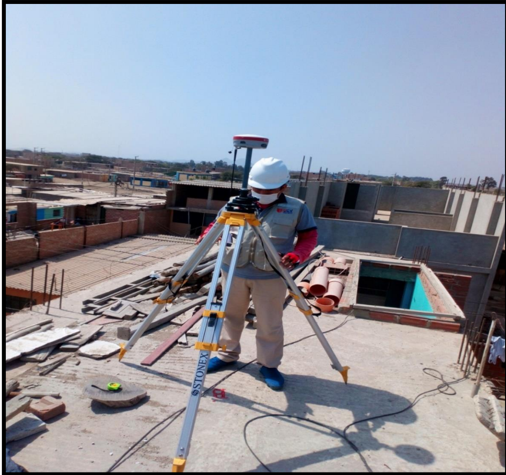
Foto 01.-Vista fotográfica de la Estación Base, con equipo Geodésico Stonex
