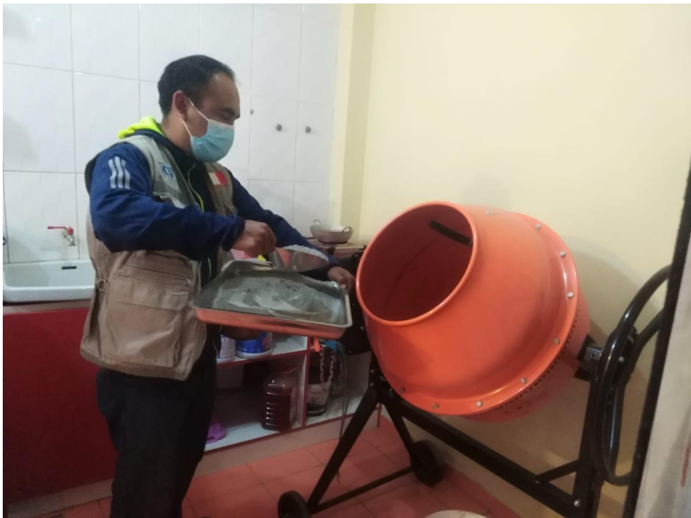
Figura 23. Mezcla de los agregados
