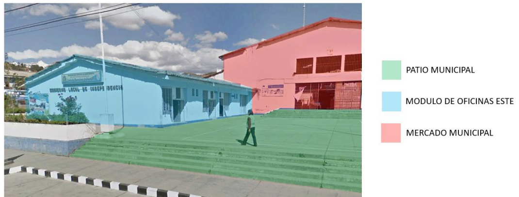
Figura 4: Módulos de infraestructura actual de la unidad consistorial de Independencia
