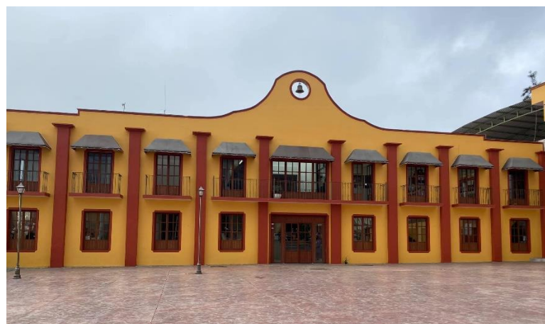
Figura 23: Fachada del Palacio Municipal de Tlalnahuayocan-México
