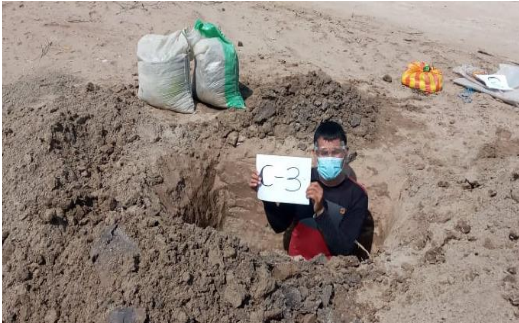
Figura: Calicata nº03
