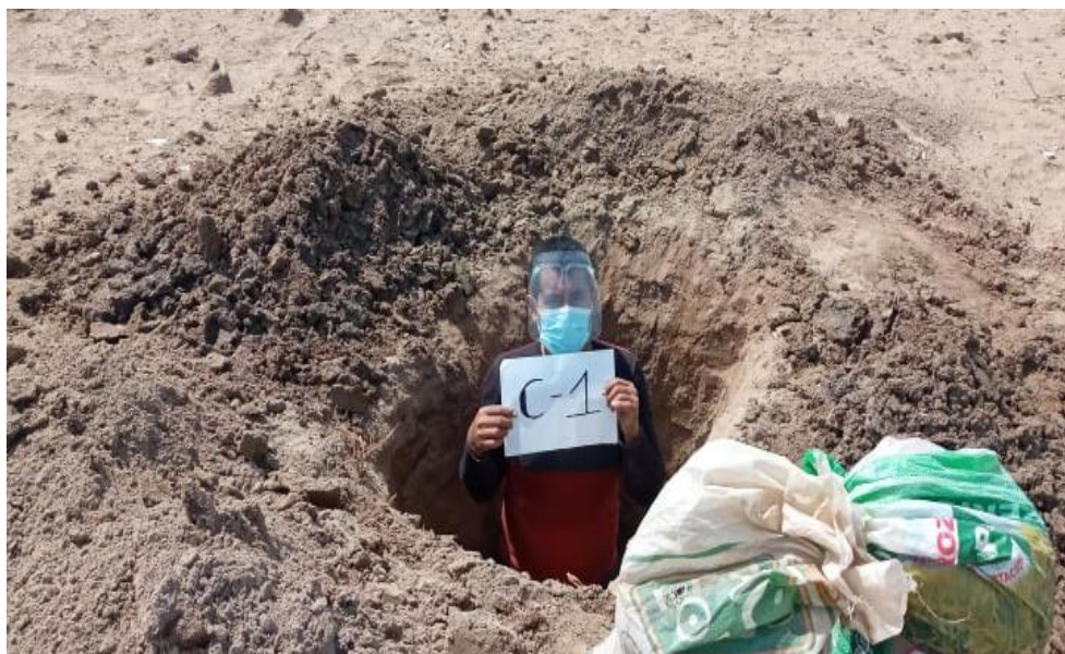
Figura: calicata nº 01
