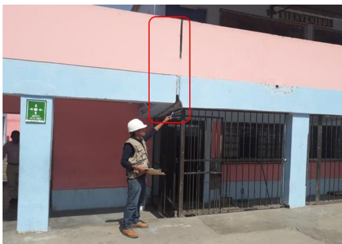
Figura 5: Junta sísmica
