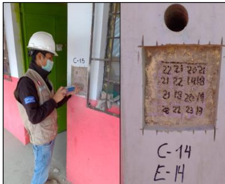
Figura 24: Ensayo de esclerometría
