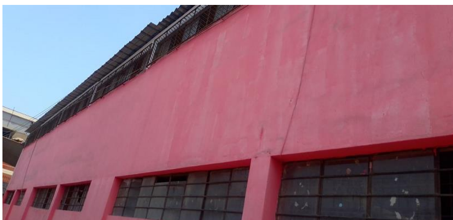
Figura 6: Columna corta
