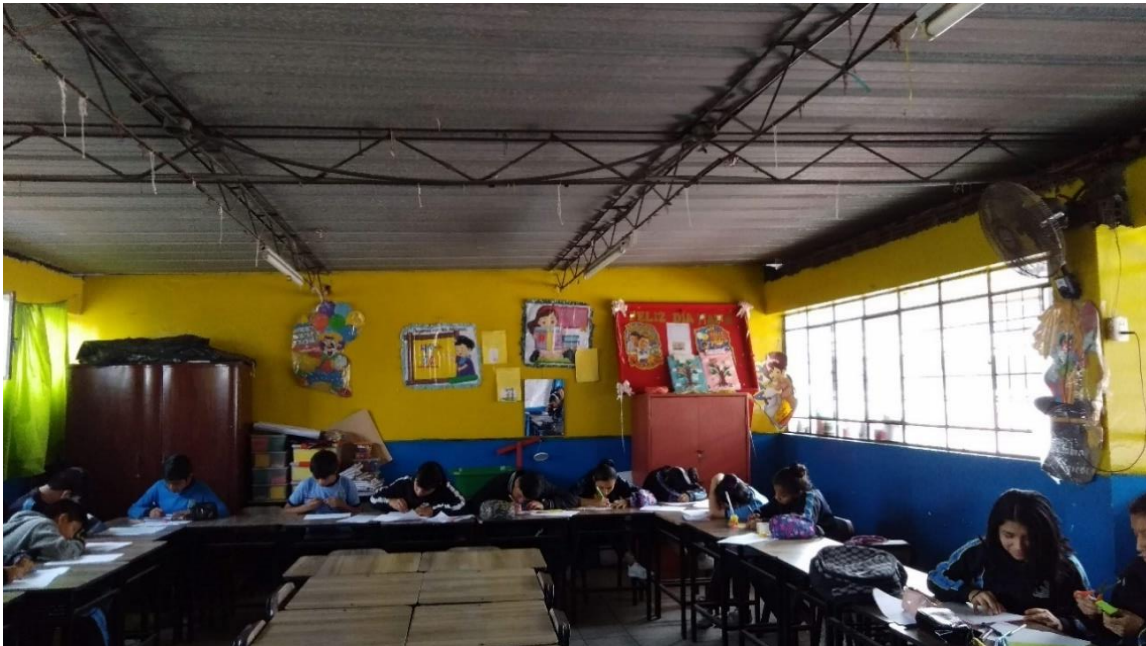
Figura 3: Techo de estructura metálica del segundo nivel
