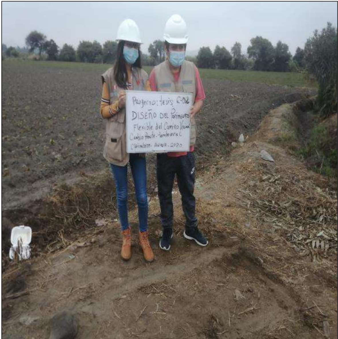
Figura 18: Preparación de terreno para calicata 02
