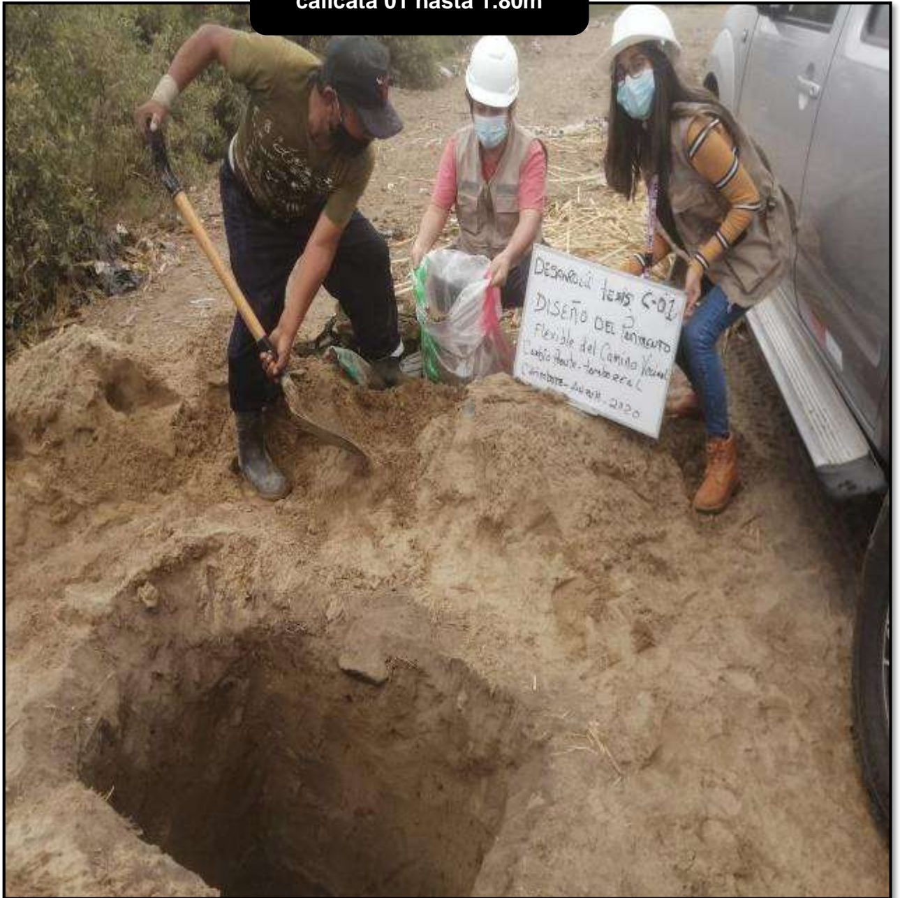
Figura 16: Excavación de calicata 01 hasta 1.80m
