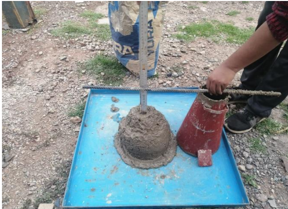
Fotografía 19. Slump concreto aligerado 5%
