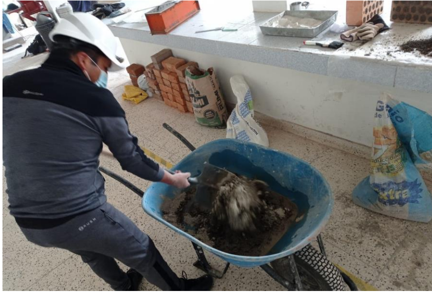
Figura 24. Mezclado de los agregados + cemento
