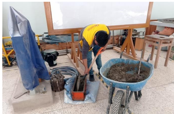
Figura 29. Viguetas de concreto
