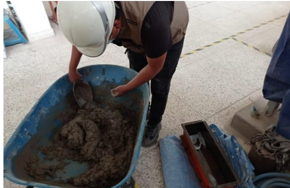
Figura 28. Incorporación del material al molde de las viguetas
