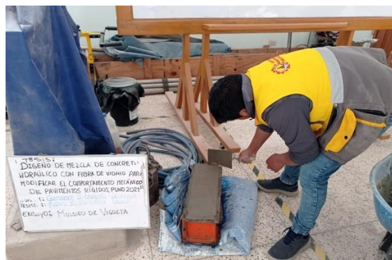
Figura 30. Moldeo de viguetas.
