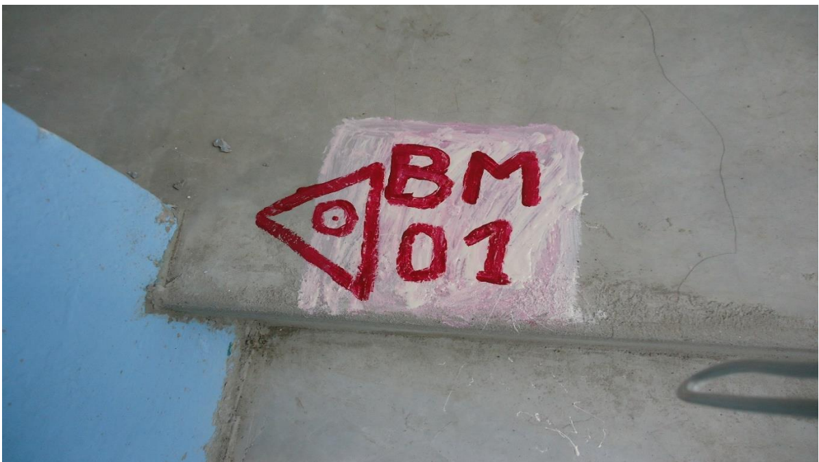
Foto N° 10. Ubicación BM-4 sobre vereda concreto
