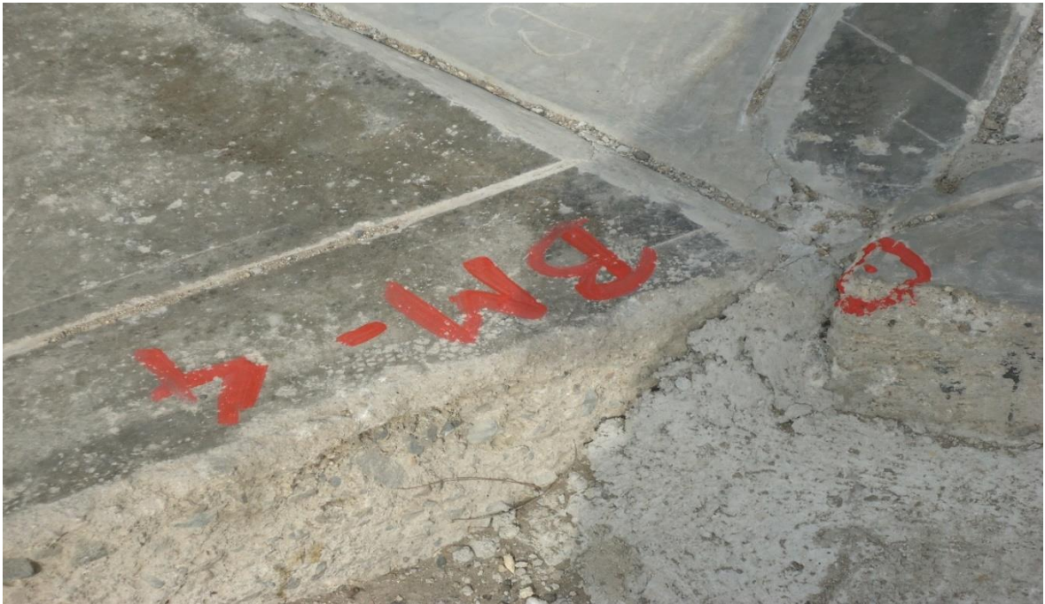
Foto N° 9. Ubicación BM-4 sobre vereda concreto
