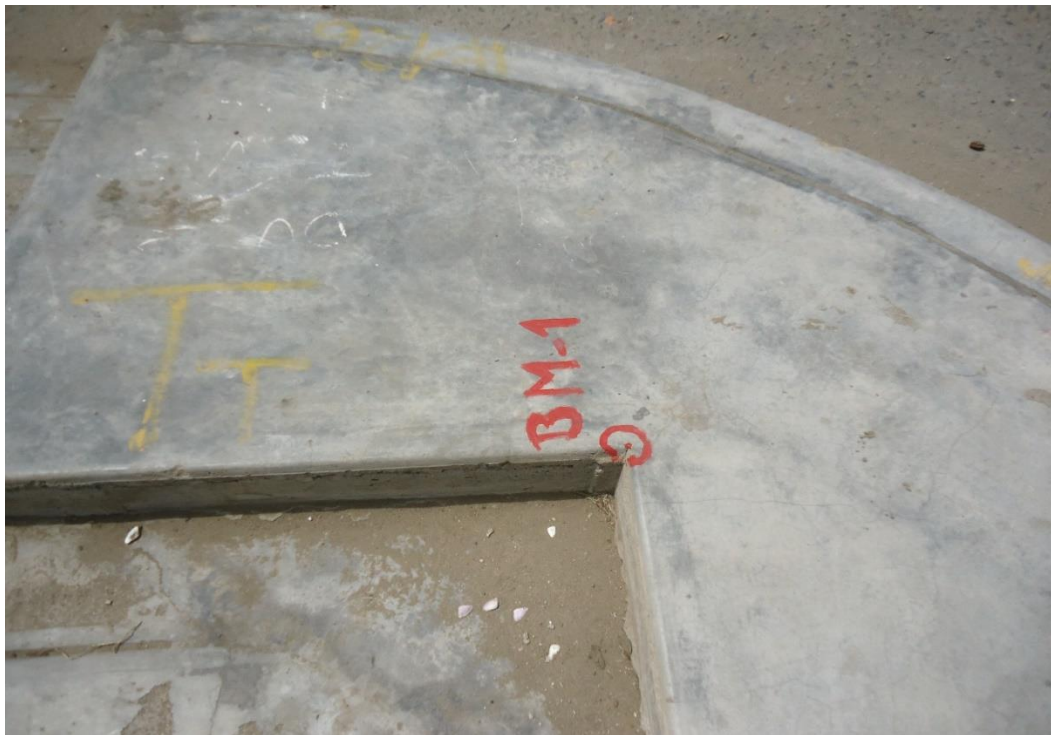
Foto N° 6. Ubicación BM-1 sobre vereda concreto
