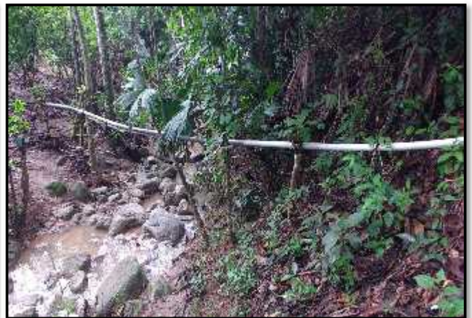
Imagen N° 05: Vista de la estructura de los pases aéreos en la Línea de Conducción.
