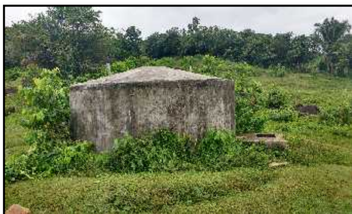
Imagen N° 07: Vista de la estructura del Reservorio, caja de válvulas que se encuentra en mal estado
