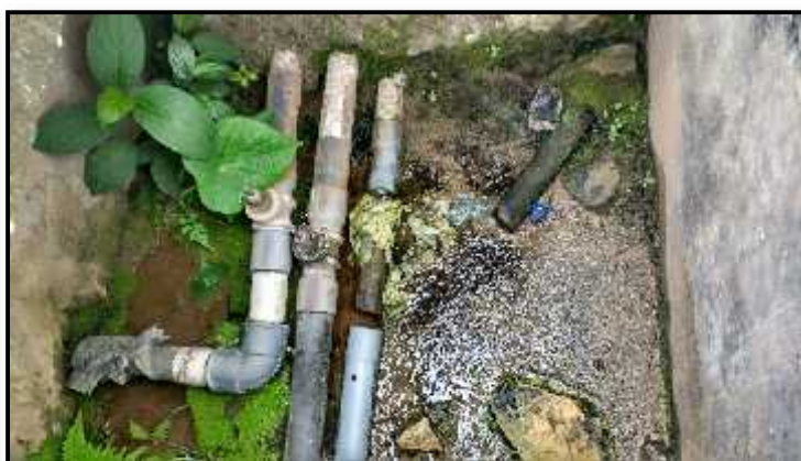
Imagen N° 07: Vista de la estructura del Reservorio, caja de válvulas que se encuentra en mal estado
