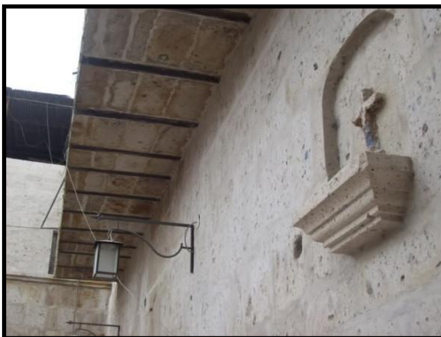
Figura: 3 Techo Aligerado con Rieles de Ferrocarril
