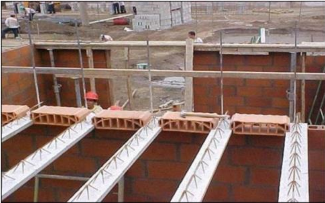
Figura: 6 Sistema de Viguetas Tralicho con Bovedilla
