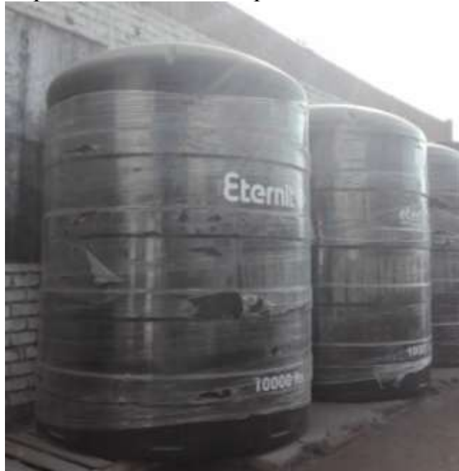
Foto 01: tanques de polietileno de una capacidad de 10 000 litros.
