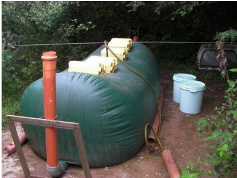
Foto 02: Depósito de almacenamiento.
