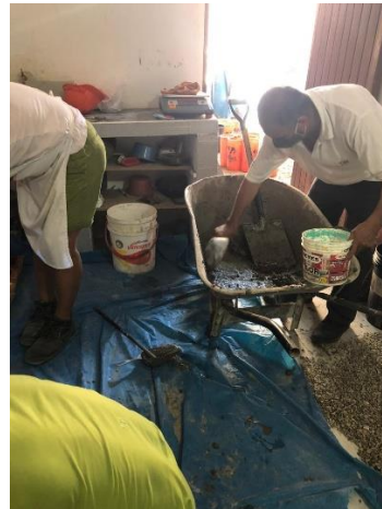
Figura 43: Residuos restantes del diseño de mezcla de concreto.
