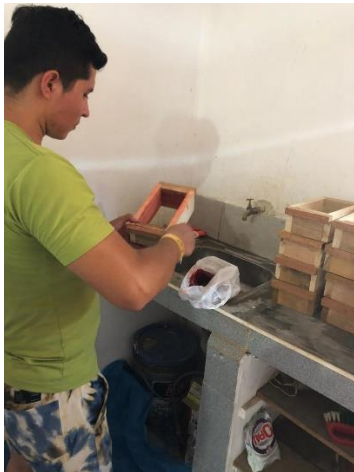
Figura 32: Engrasamiento de los moldes de los adoquines.
