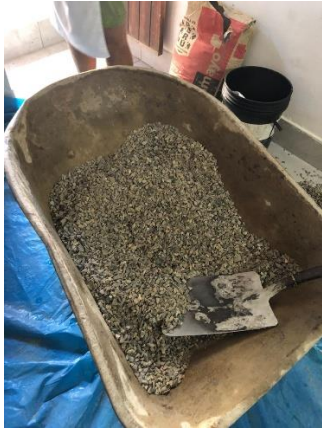
Figura 34: Preparación de los agregados.
