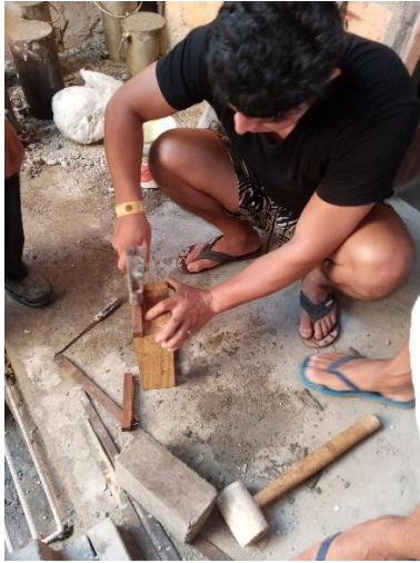
Figura 50: Desencofrado de los adoquines de concreto.
