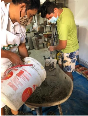
Figura 38: Incorporación de agua a la mezcla.
