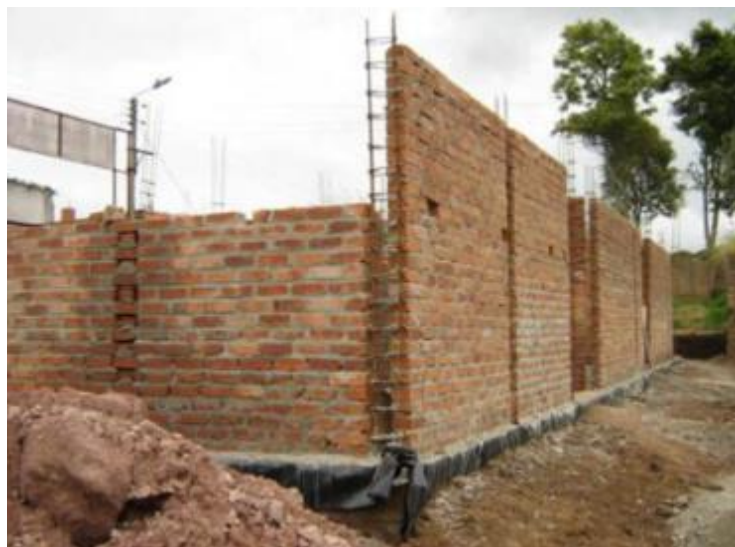
Figura 21. Muros de mampostería Fuente: https://bit.ly/3uXWhWe
