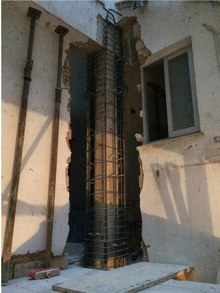
Figura 1. Encamisado de columna Fuente: https://bit.ly/3BqUiOA
