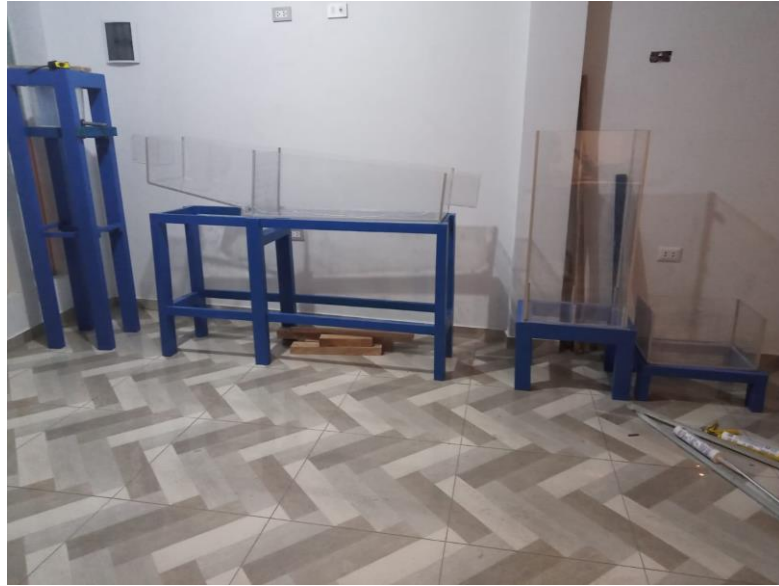
Imagen 14. Elaboración de la estructura hidráulica.
