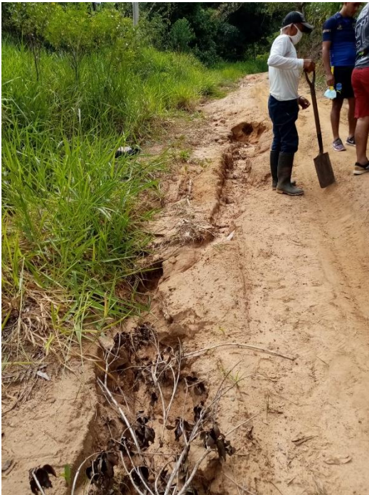
DONDE SE REALIZO LA CALICATA
