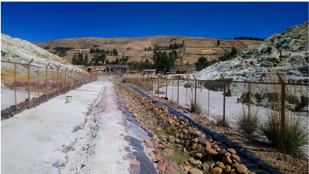
Imagen 12. Inspección ocular de las aguas de la quebrada Yarush
