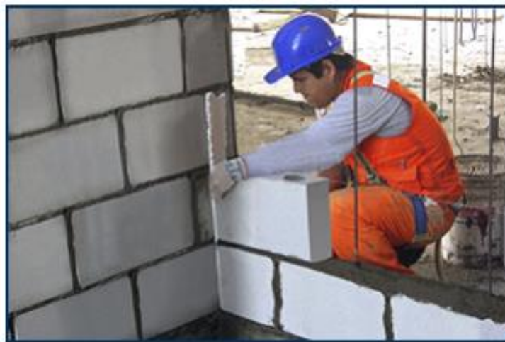
Figura 6: Colocación de la Placa P-14 (Lacasa,2021)
