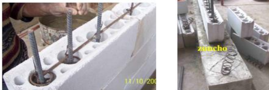
Figura 11: Refuerzo horizontal y zunchos en M-2
