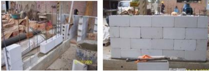
Figura 10:Asentamiento de la primera hilada y apilamiento en las hiladas superiores
