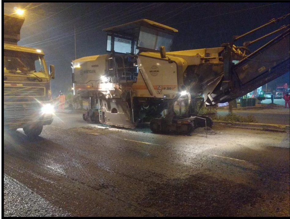
Figura 3. Proceso de Fresado con la maquinaria Wirtgen. Fuente: Propia
