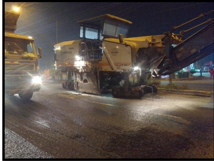
Figura 13. Proceso de fresado. Fuente: Propio
