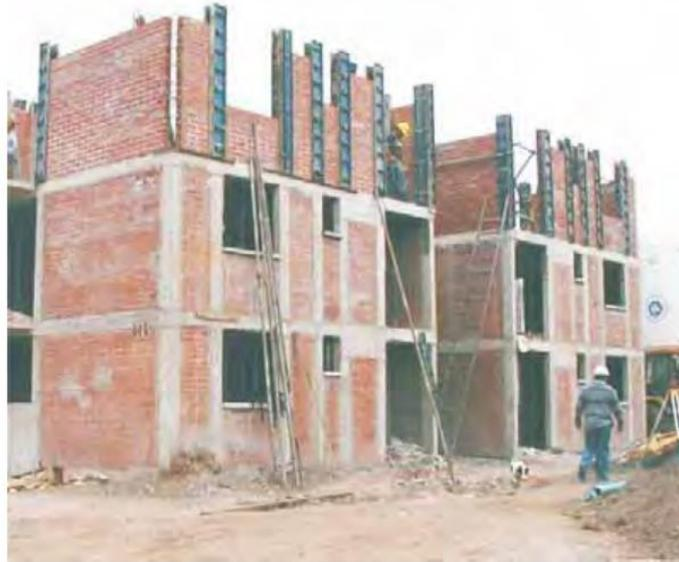
Figura 1: Albañilería confinada en proceso constructivo
