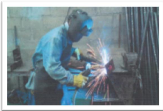
FIGURA 01. SERVICIO DE SOLDADURA
