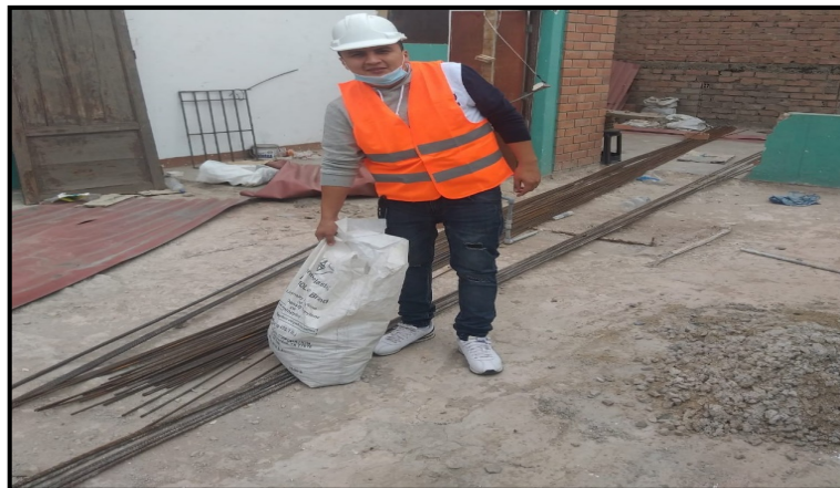
Fotografía 2. Realizando la extracción del concreto demolido.
