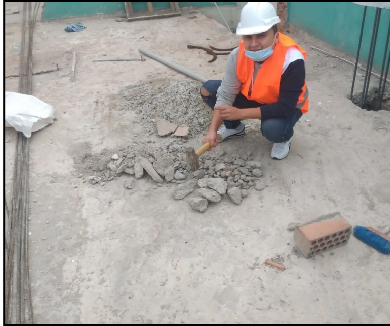
Fotografía 3. La trituración del concreto de demolición.
