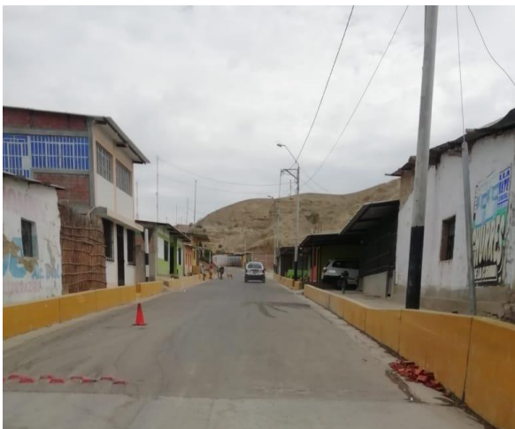
Figura 1.1 Prog 0+000 - Inicio de la vía
