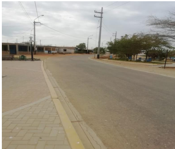
Figura 2.1 Prog 0+570 – Final de vía
