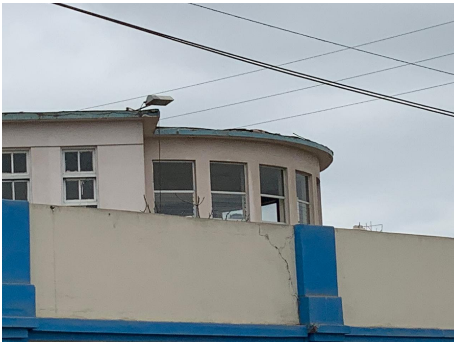
Parte lateral del Hospital (Fuente: Elaboración Propia)
