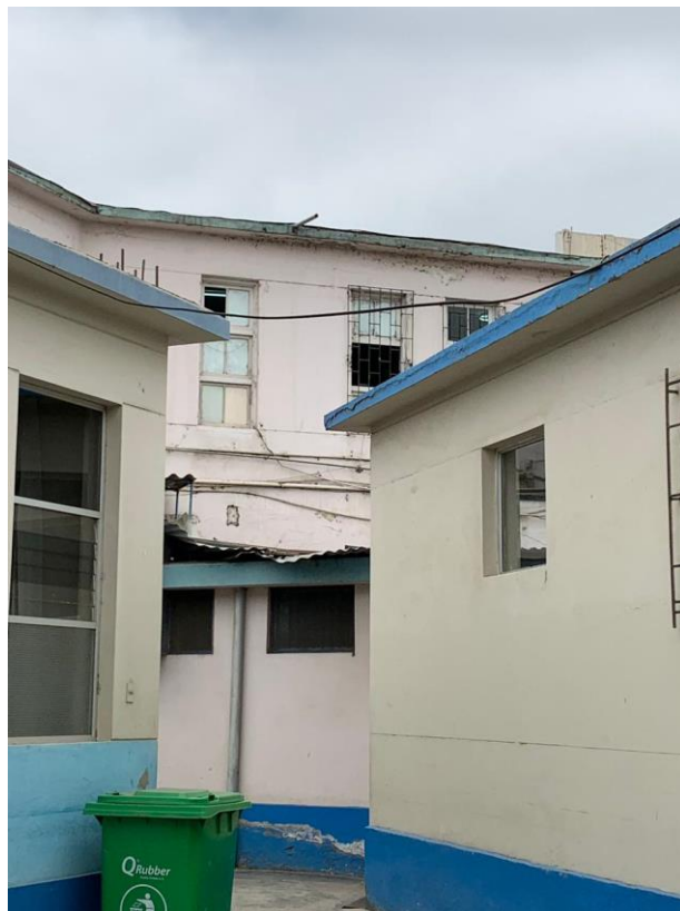
Interiores (Fuente: Elaboración Propia)
