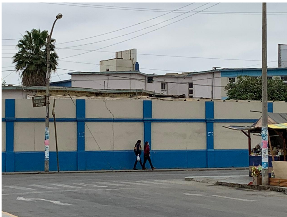
Parte lateral del Hospital (Fuente: Elaboración Propia)
