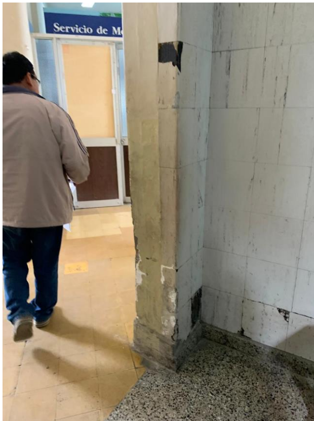
Interiores (Fuente: Elaboración Propia)
