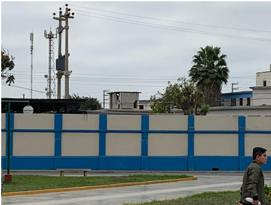
Parte lateral del Hospital (Fuente: Elaboración Propia)
