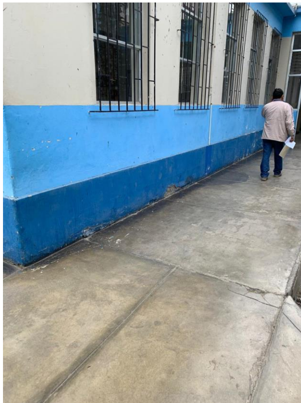
Interiores (Fuente: Elaboración Propia)
