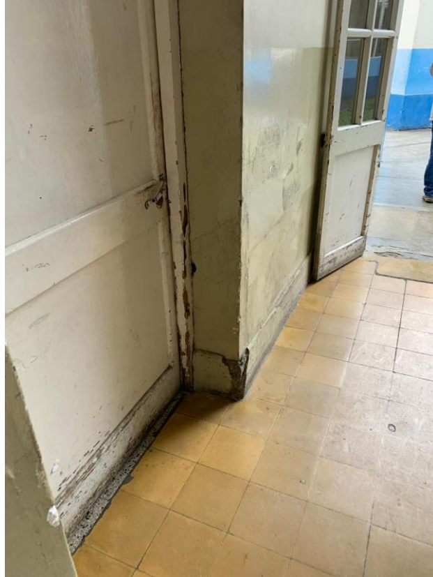
Interiores (Fuente: Elaboración Propia)
