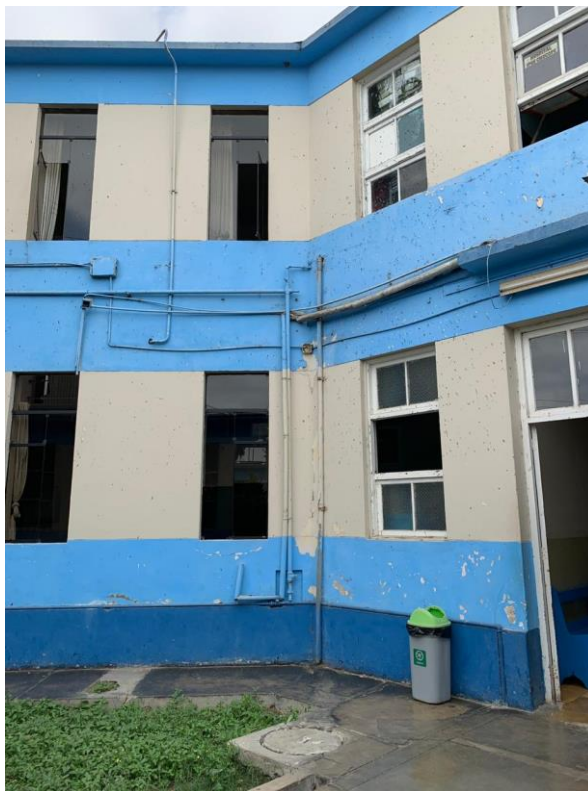
Interiores (Fuente: Elaboración Propia)
