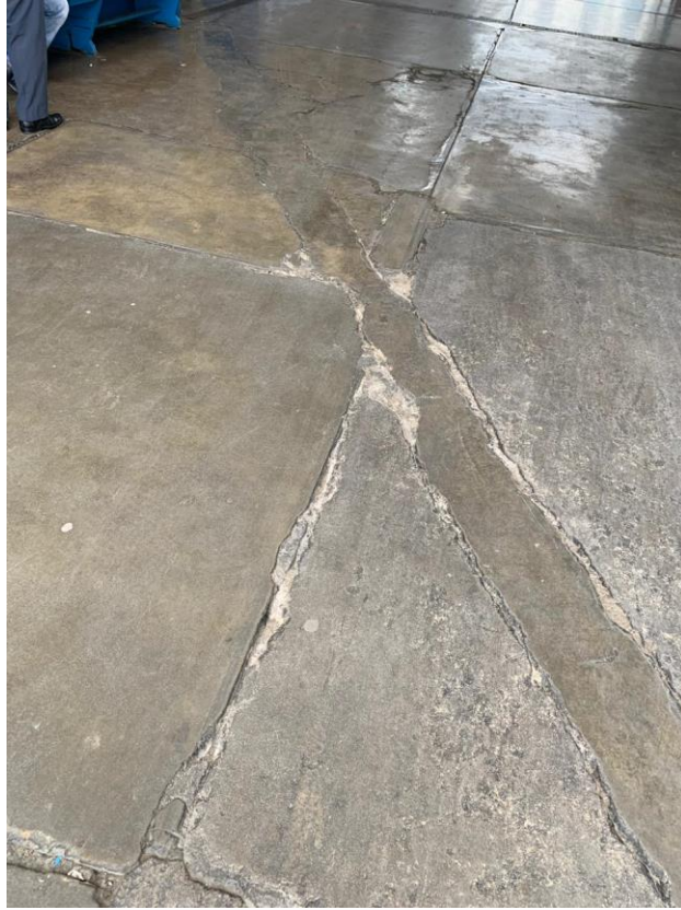
Interiores (Fuente: Elaboración Propia)
