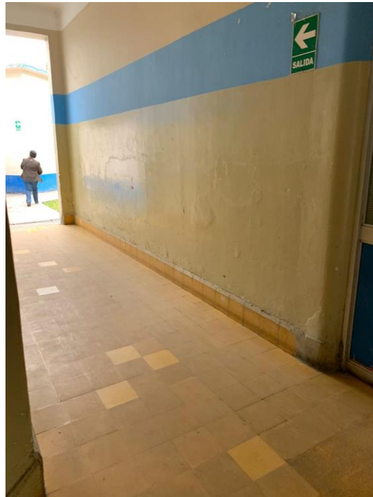
Pasillos (Fuente: Elaboración Propia)
