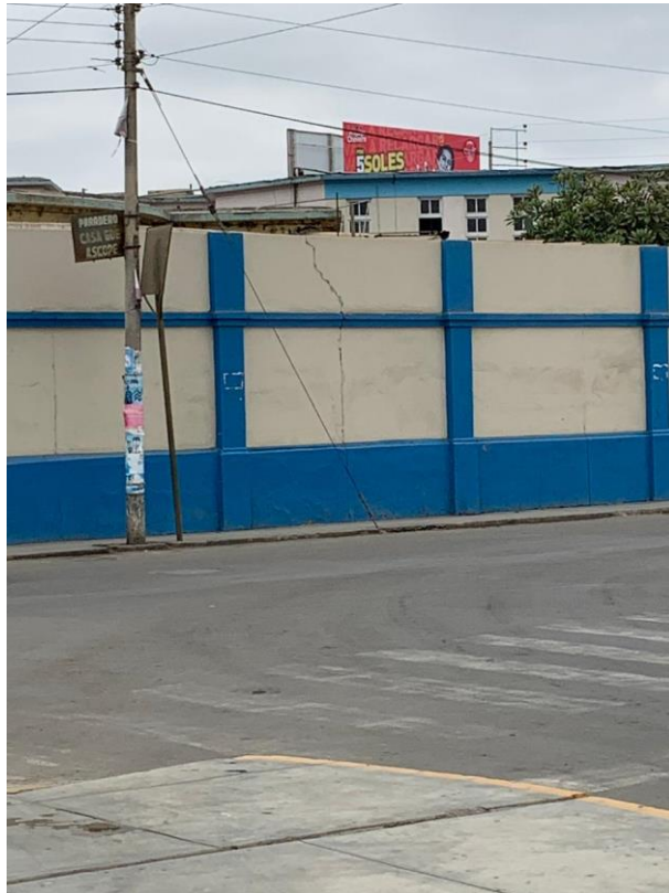
Parte lateral del Hospital (Fuente: Elaboración Propia)
