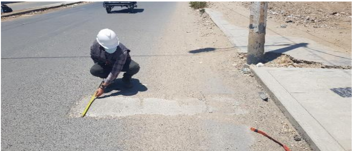
Fotografía 6: UM 09 tramo II derecho, progresiva 1+0556 (Parcheo).
