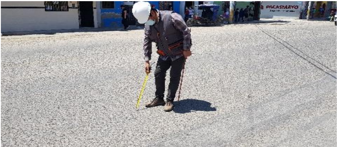
Fotografía 5: UM 04 tramo II derecho, progresiva 0+396 (Pulimiento de agregados).
