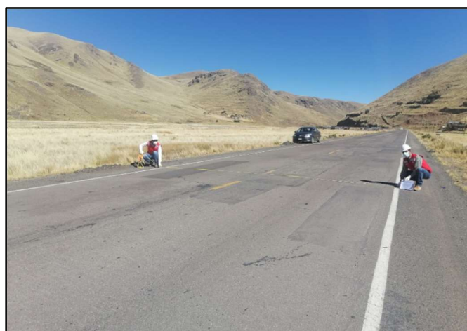
Figura 20: Medición de la sección de la carretera.
