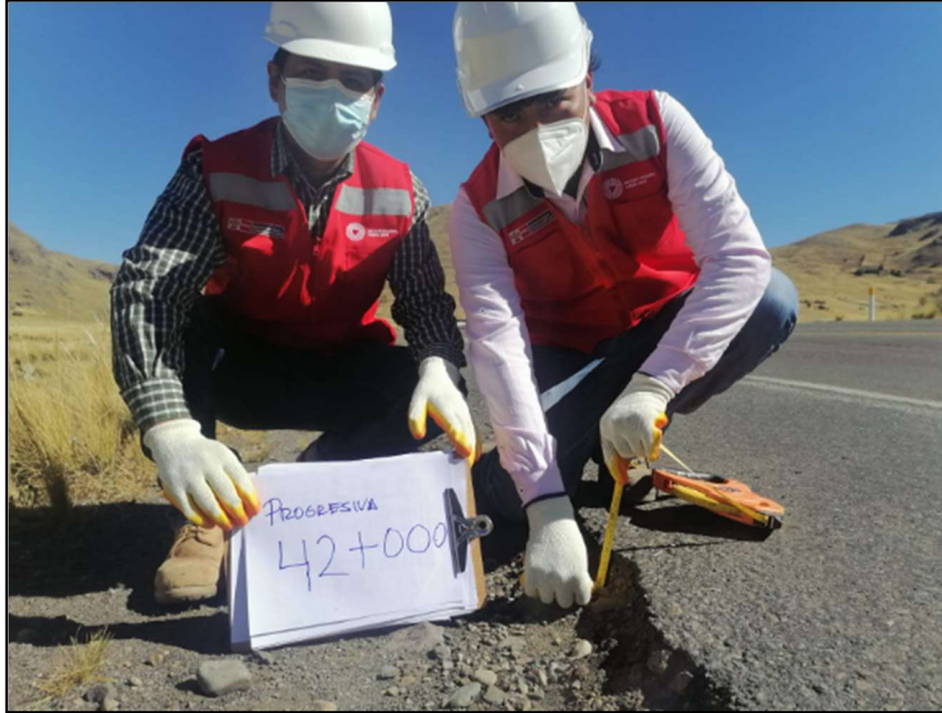
Figura 17: Daños en la base producidos por factores climáticos.
