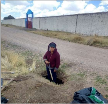
Elaboración de calicatas
