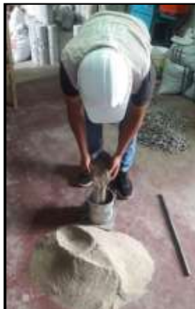
Colocación de la arena
