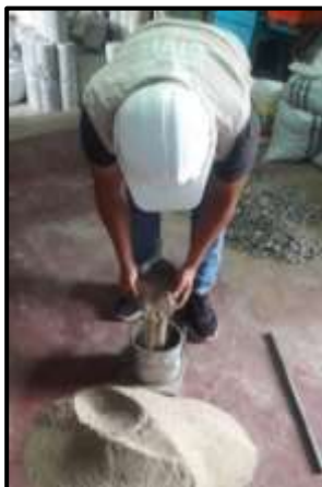
Colocación de la arena
