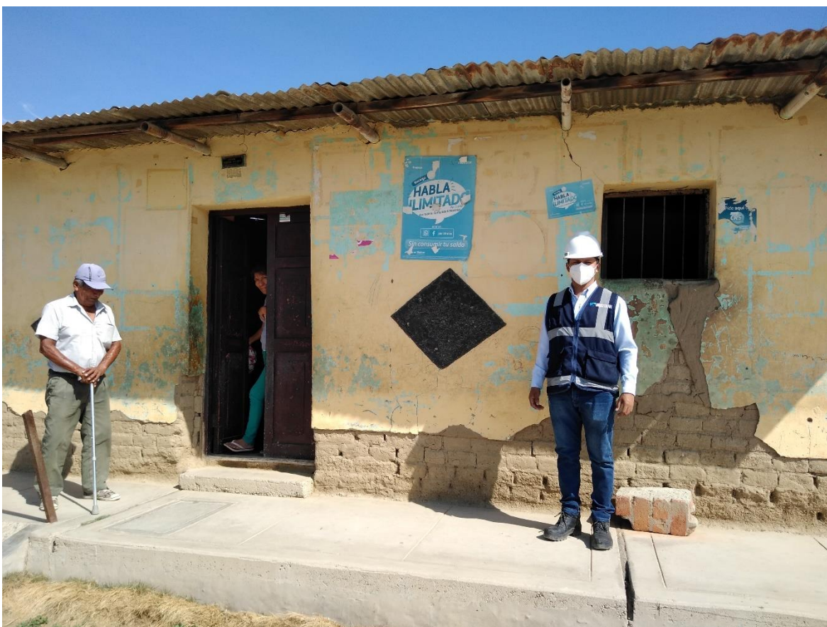
Fotografía 02: Inspección al área de estudio
