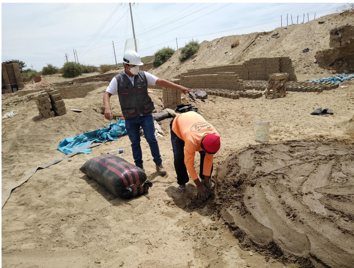
Fotografía 05: Elaboración de adobes
