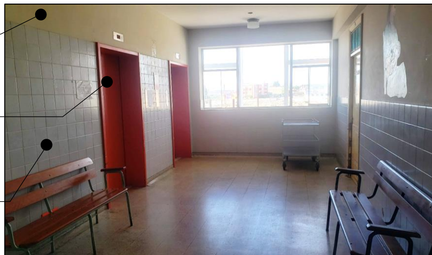
HALL DE ASCENSORES
