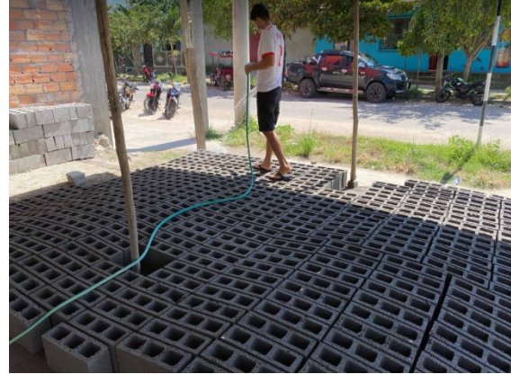
Curado del concreto a durante 24 horas.
