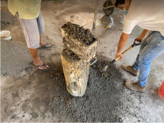
Armado de los bloques de concreto.
