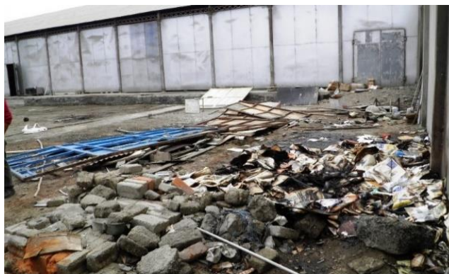
Figura 11: Patio interior del ex Ferrocarril de Chimbote Huallanca.
