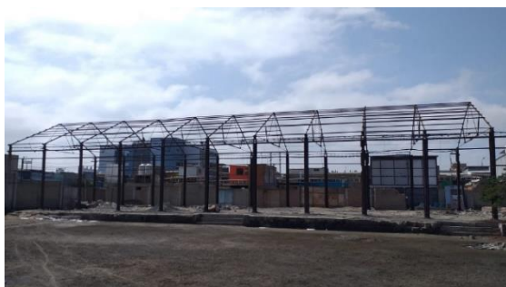
Figura 09: Estructura de una de las naves de la exestación del Ferrocarril Chimbote Huallanca.
