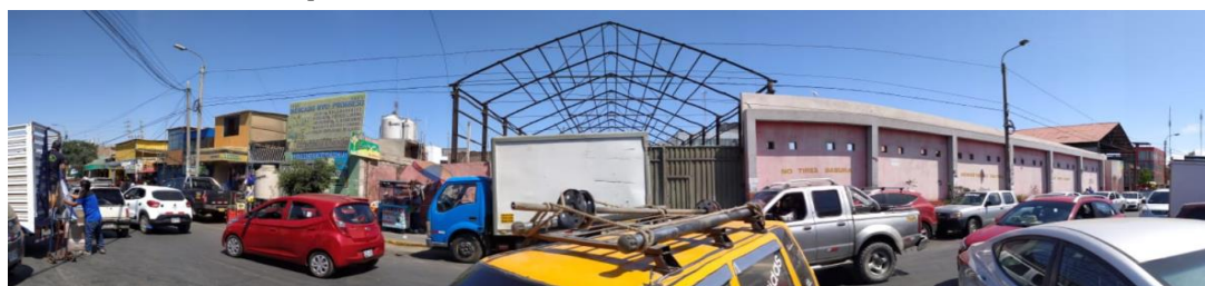
Figura 34: Fotografía del terreno Prolongación Leoncio Prado.
