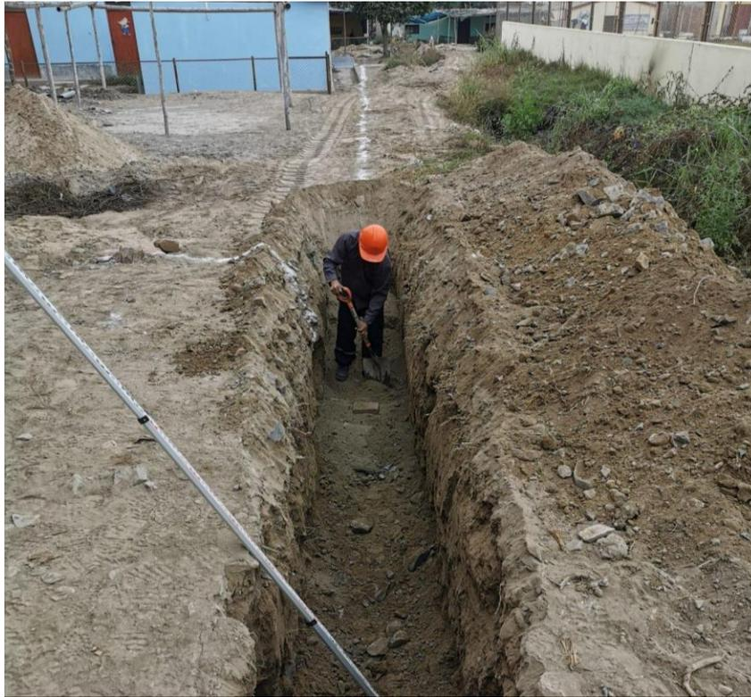
*Figura 7. Excavación de zanjas para la colocación de tuberías*
