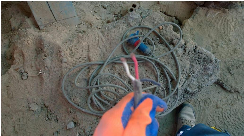
Figura 4. Cables en mal estado
