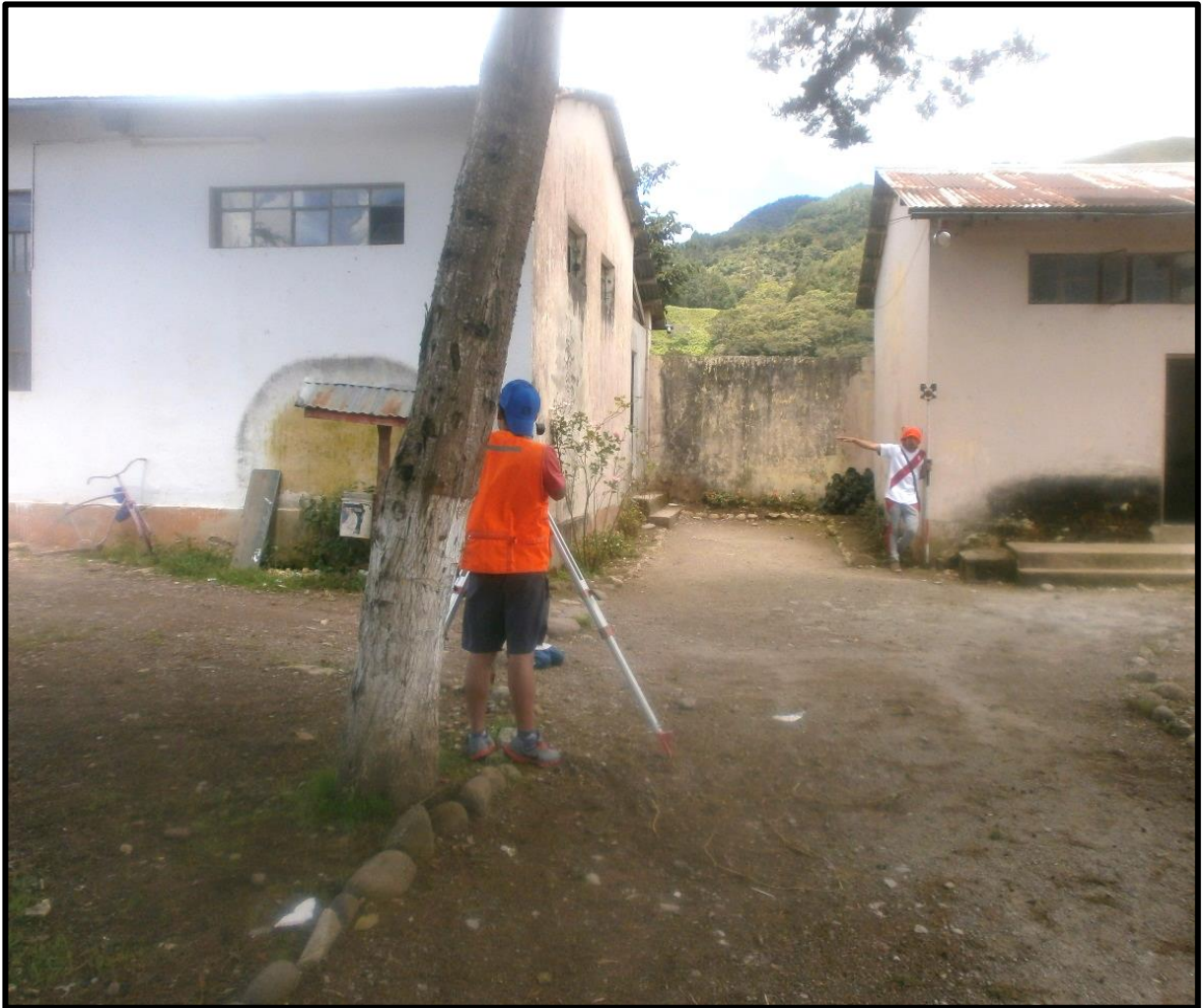
Figura 26 Trabajos topográficos – foto 4.
