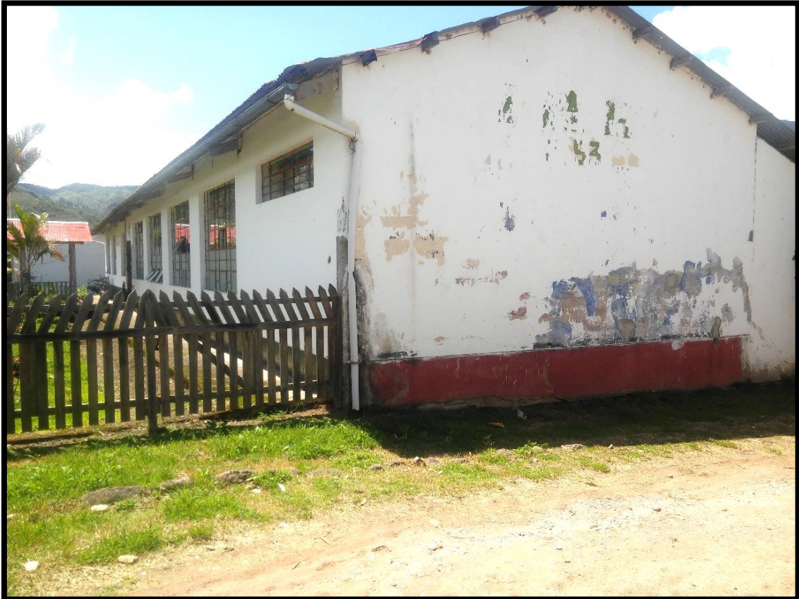
Figura 18 Vista del pabellón del nivel secundario.
