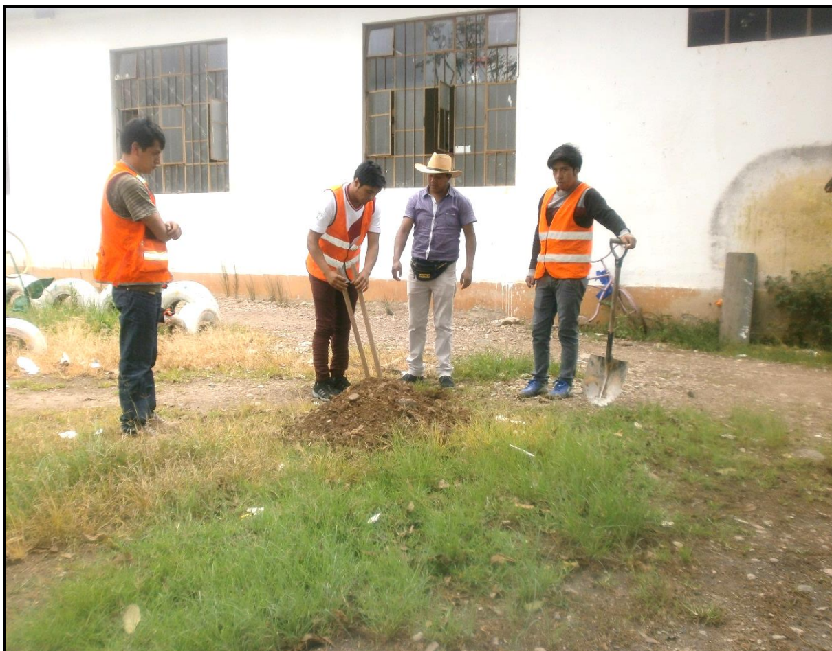
Figura 33 Realización de calicatas – foto 4.
