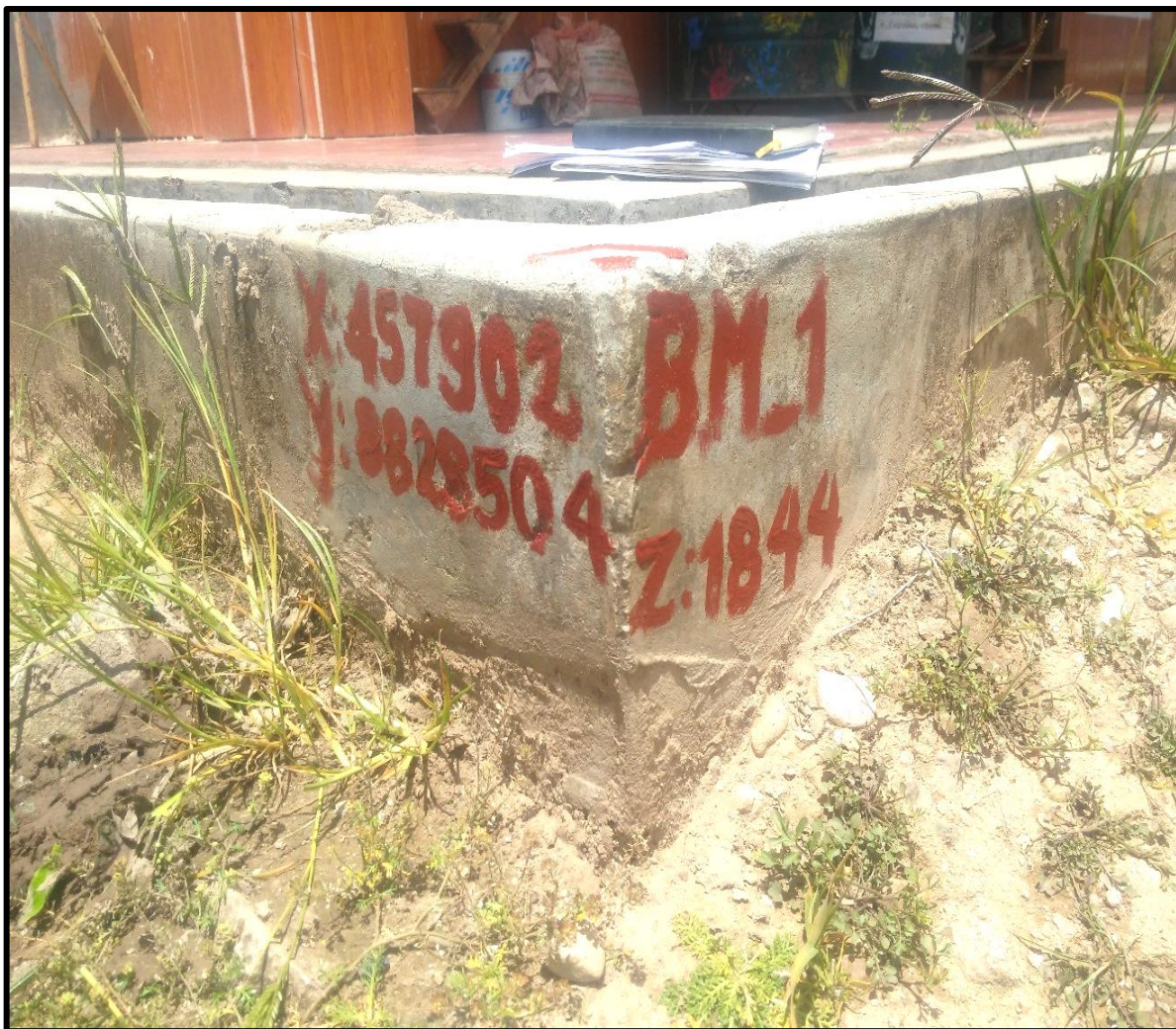
Figura 25 Trabajos topográficos – foto 3.
