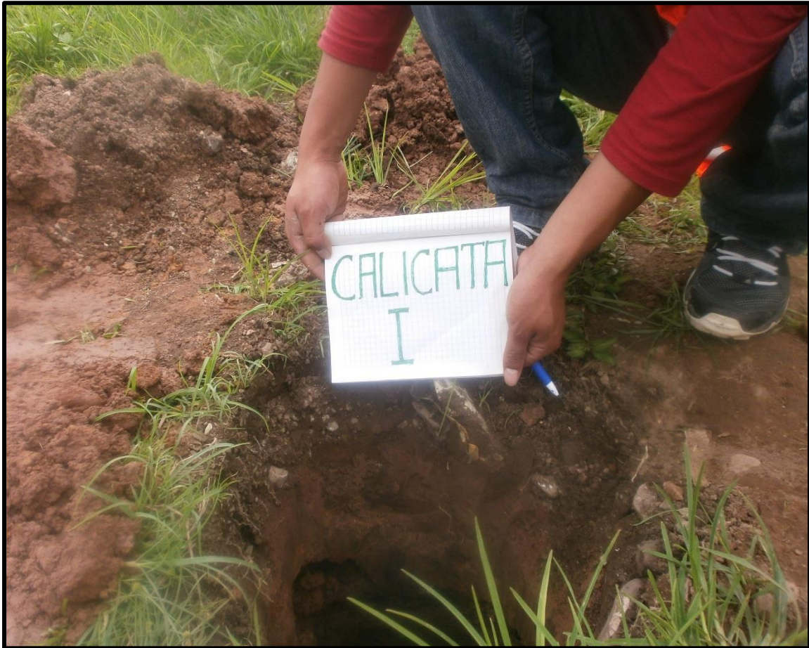
Figura 30 Realización de calicatas – foto 1.
