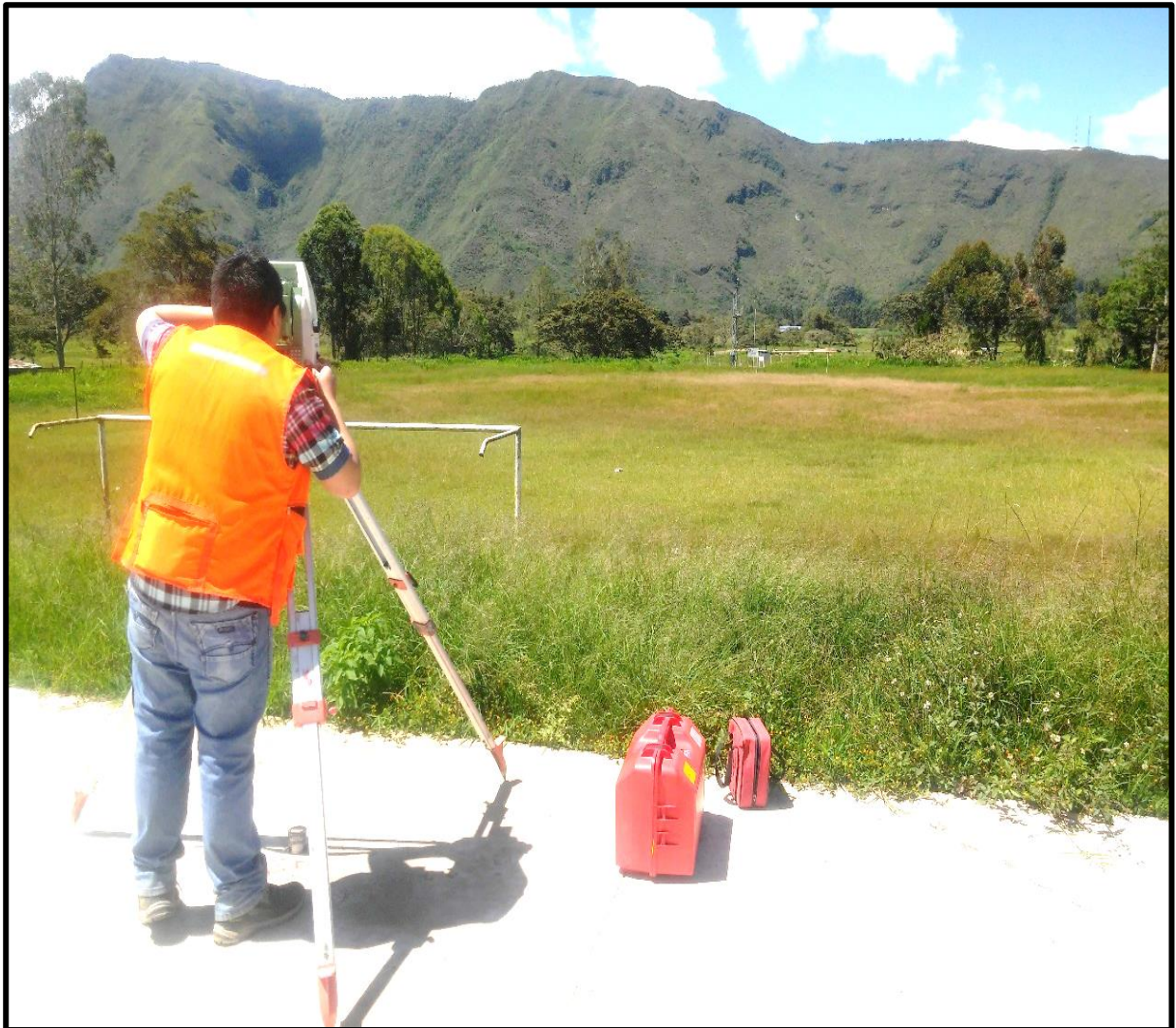
Figura 23 Trabajos topográficos – foto 1.
