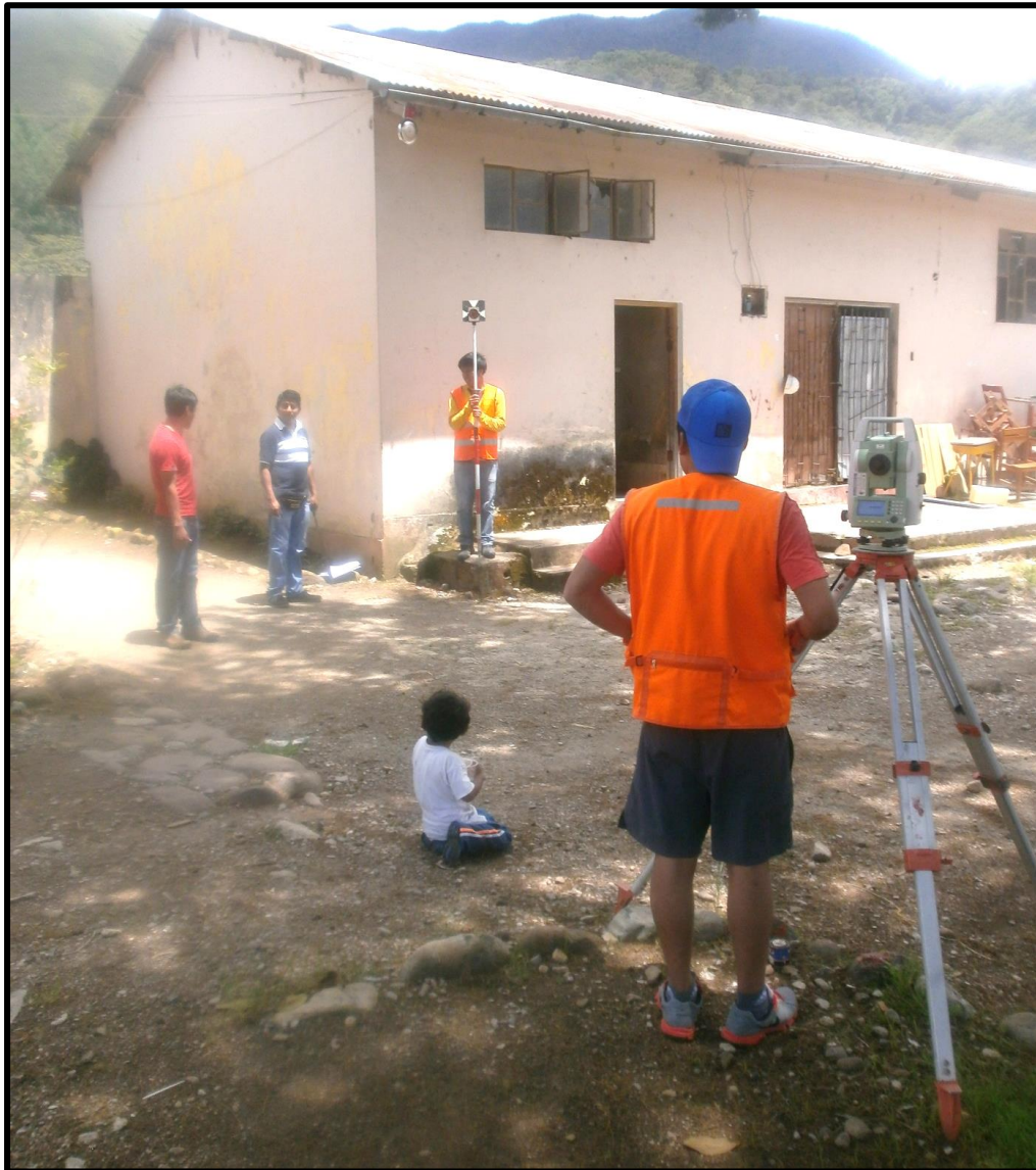
Figura 27 Trabajos topográficos – foto 5.
