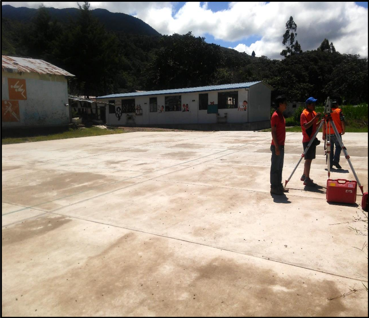
Figura 24 Trabajos topográficos – foto 2.
