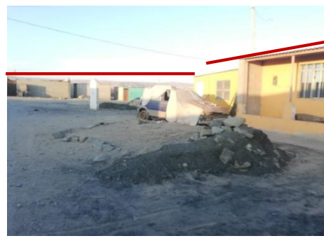
4. Viviendas de un solo nivel, acumulación de basura.
