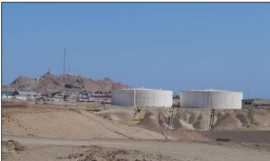
Figura 11: Depósito de Agua Potable
