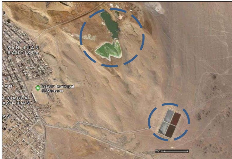
Figura 14: Tratamiento de Aguas Residuales
