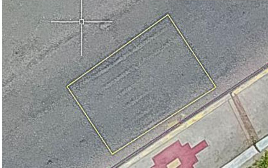
Figura 44. Sección 0+060 - 0+120, Ahuellamiento.
