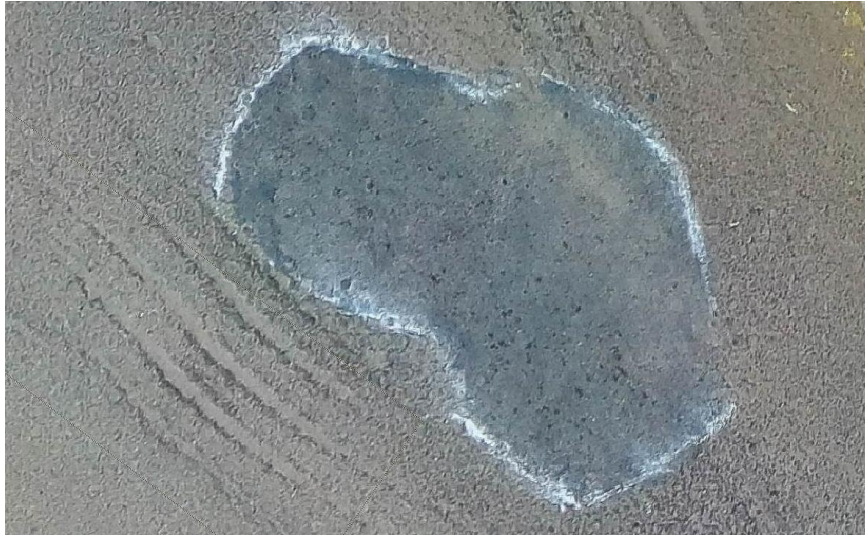
Figura 34. Sección 0+000 - 0+060, Parcheo.
