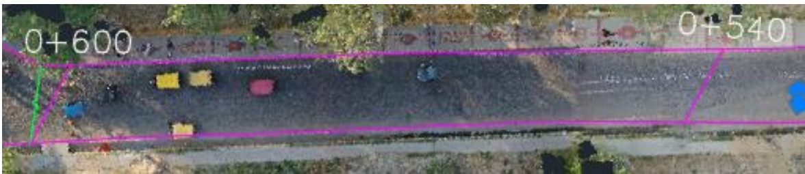
Figura 58. Sección 0+540 - 0+600, Pulimiento de agregados.
