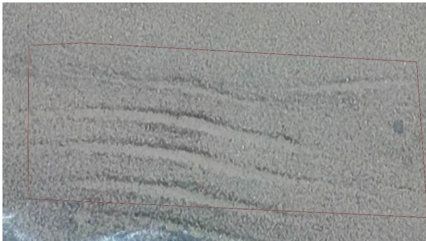
Figura 35. Sección 0+000 - 0+060, Ahuellamiento
