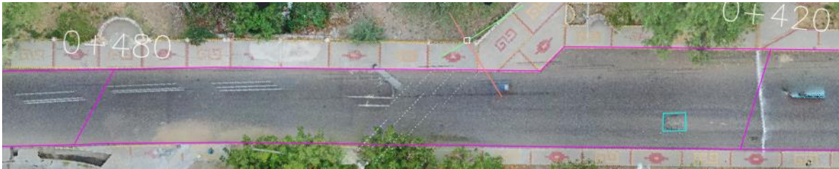
Figura 55. Sección 0+420 - 0+480, Pulimiento de agregados.
