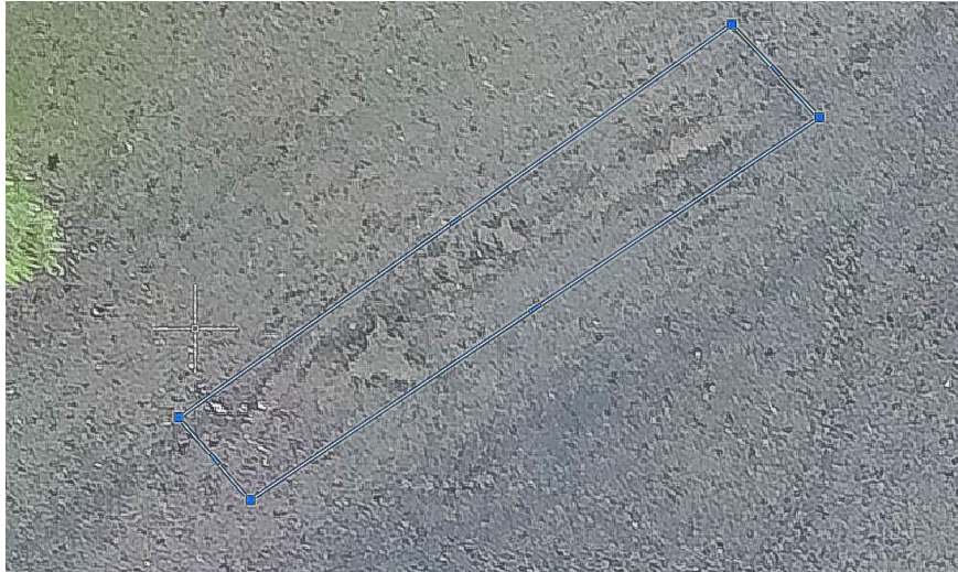
Figura 40. Sección 0+000 - 0+060, Ahuellamiento
