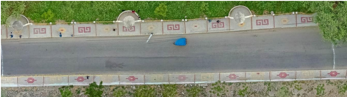
Figura 45. Sección 0+060 - 0+120, Pulimiento de agregados.
