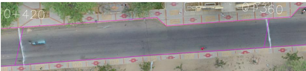
Figura 53. Sección 0+360 - 0+420, Pulimiento de agregados.
