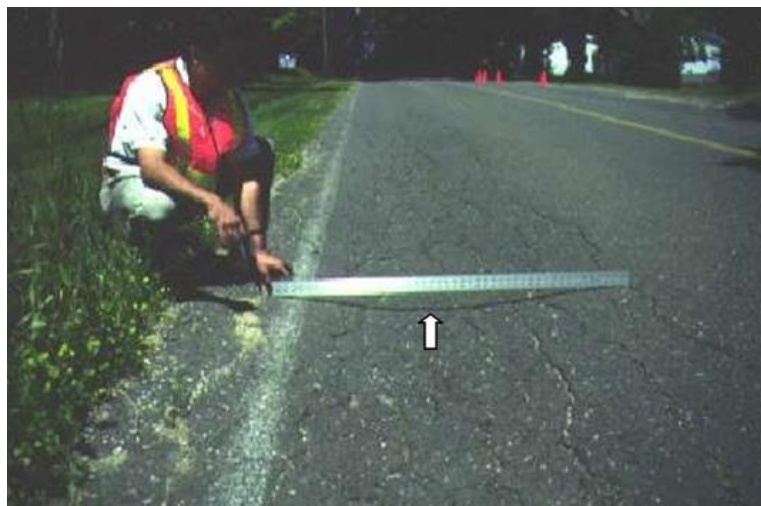
Figura 6. Depresión (Fuente: ingenieriareal.com)
