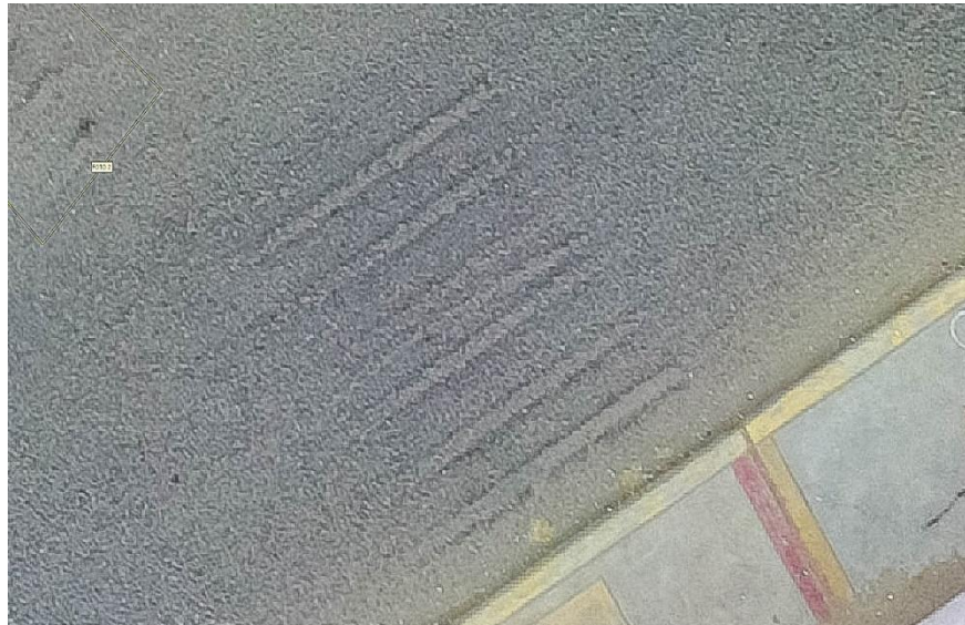
Figura 42. Sección 0+060 - 0+120, Ahuellamiento.
