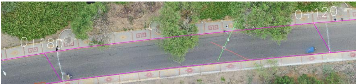
Figura 46. Sección 0+120 - 0+180, Pulimiento de agregados.
