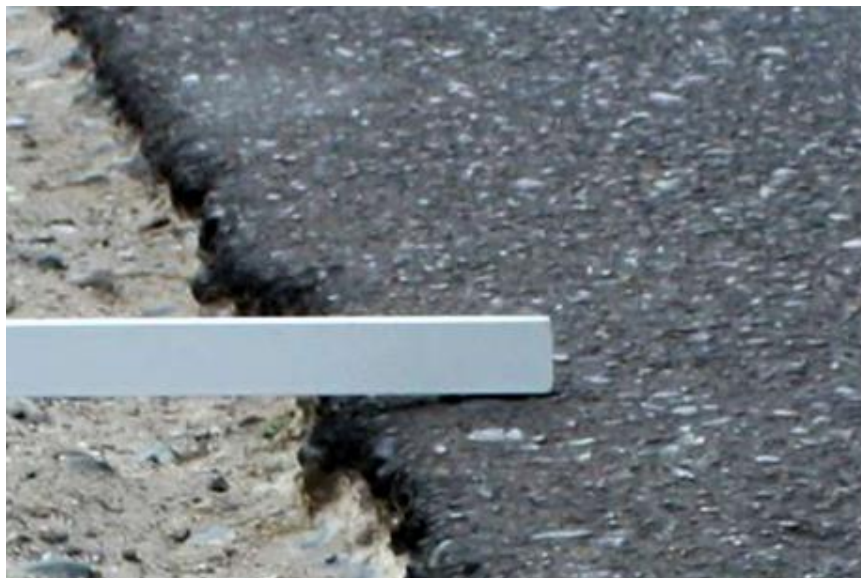
Figura 9. Desnivel Carril berma (Fuente: ingenieriareal.com)
