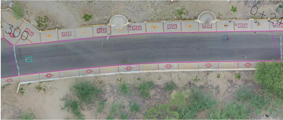
Figura 50. Sección 0+240 - 0+300, Pulimiento de agregados.
