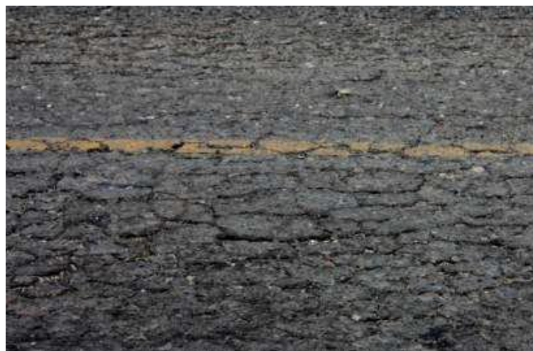
Figura 1. Piel de cocodrilo (Fuente: ingenieriareal.com)
