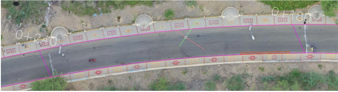
Figura 48. Sección 0+180 - 0+240, Pulimiento de agregados.
