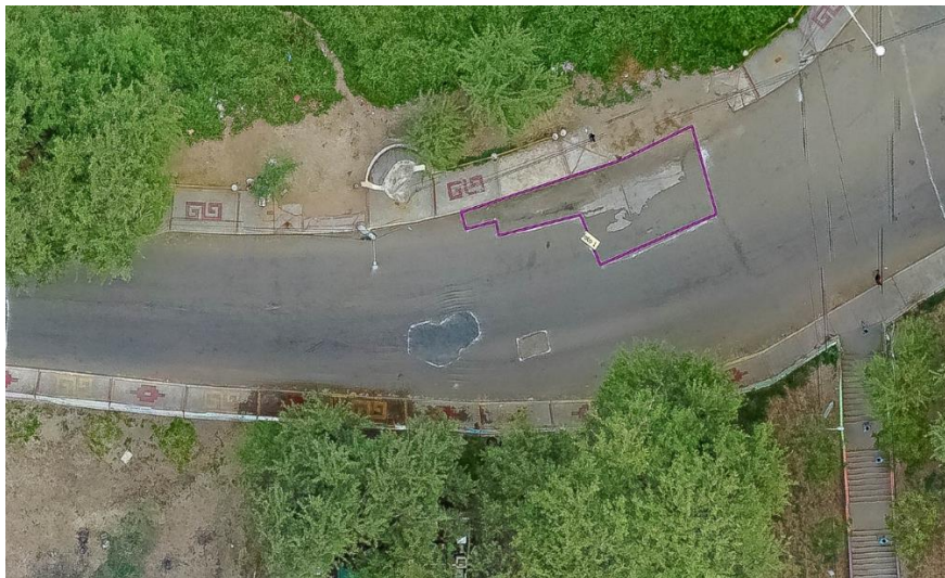
Figura 41. Sección 0+000 - 0+060, Pulimiento de agregados.
