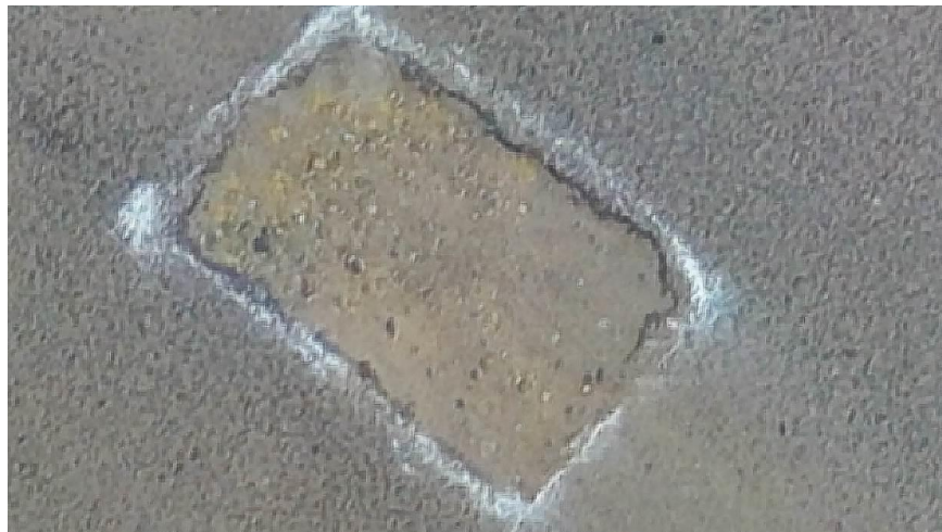
Figura 33. Sección 0+000 - 0+060, Huecos
