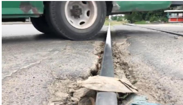
Figura 14. Cruce de vía férrea (Fuente: Guerrero 2018)
