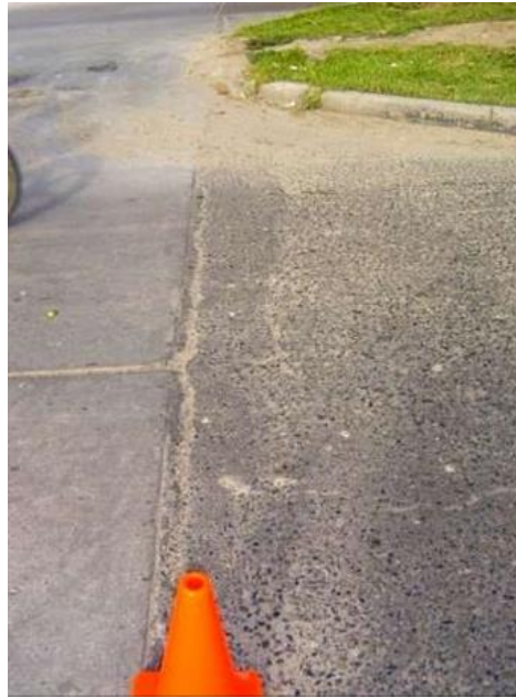
Figura 16. Desplazamientos (Fuente: ingenieriareal.com)
