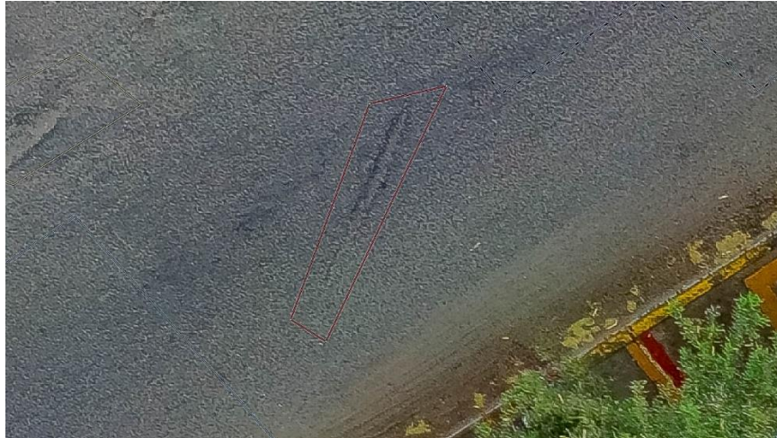
Figura 38. Sección 0+000 - 0+060, Ahuellamiento
