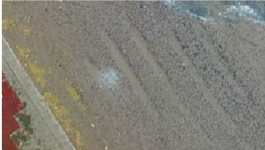
Figura 36. Sección 0+000 - 0+060, Ahuellamiento
