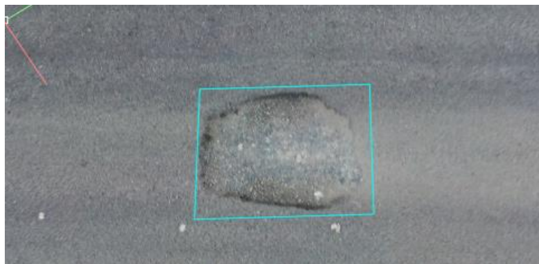
Figura 54. Sección 0+420 - 0+480, Parcheo.
