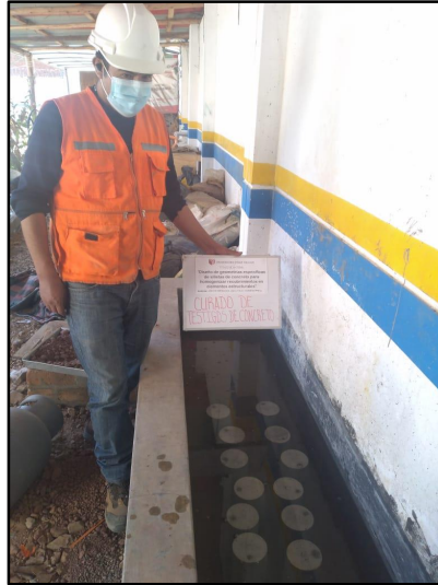
Figura 12. Curado de las silletas de concreto.
