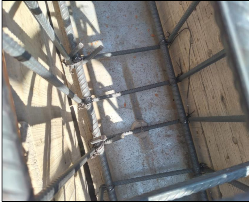
Figura 18. Columnas con sus respectivas silletas.
