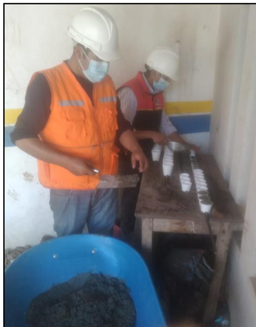
Figura 11. Moldeo de las silletas con concreto.
