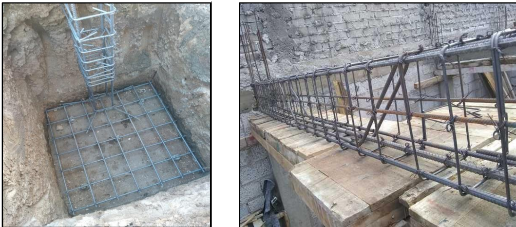
Figura 7. Armaduras de columna y viga.
